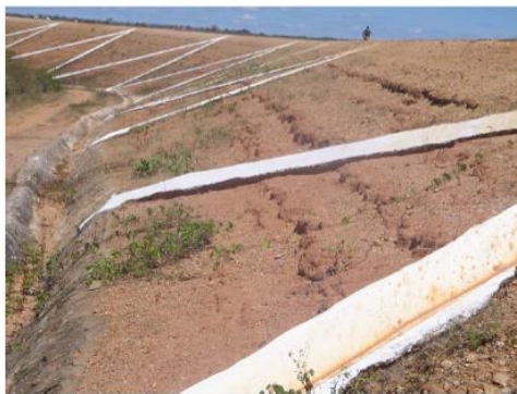
(a) Talude de jusante sem revestimento
