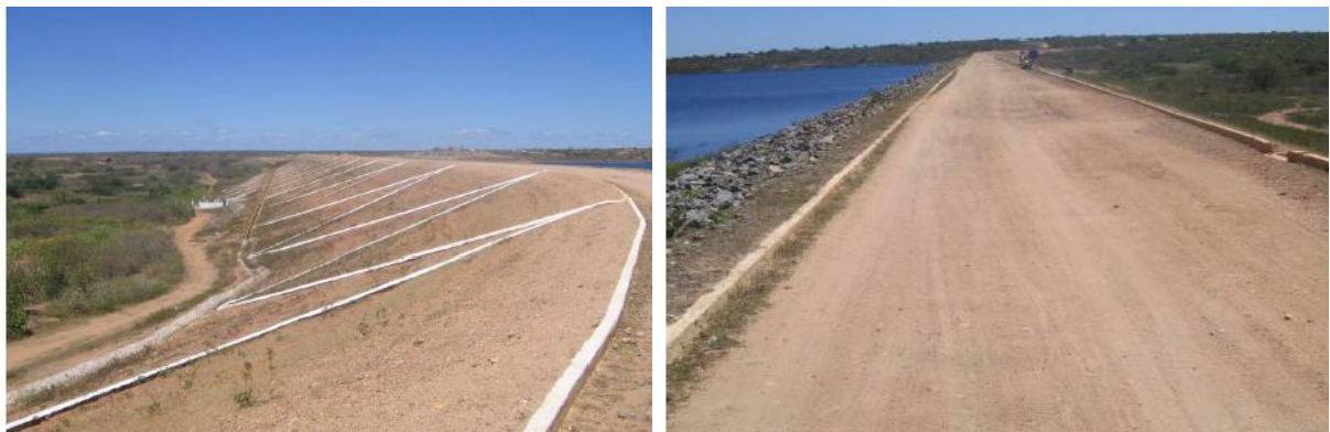
(a) Vista lateral - Talude de jusante
