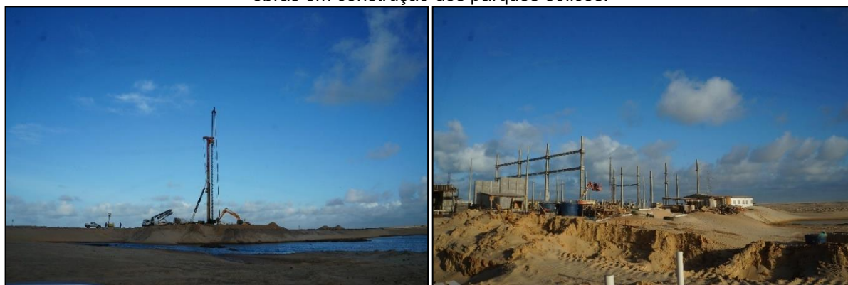
Figuras 62 e 63 - Processo de concretagem da base para suportar a torre de geração e canteiro de obras em construção dos parques eólicos.
