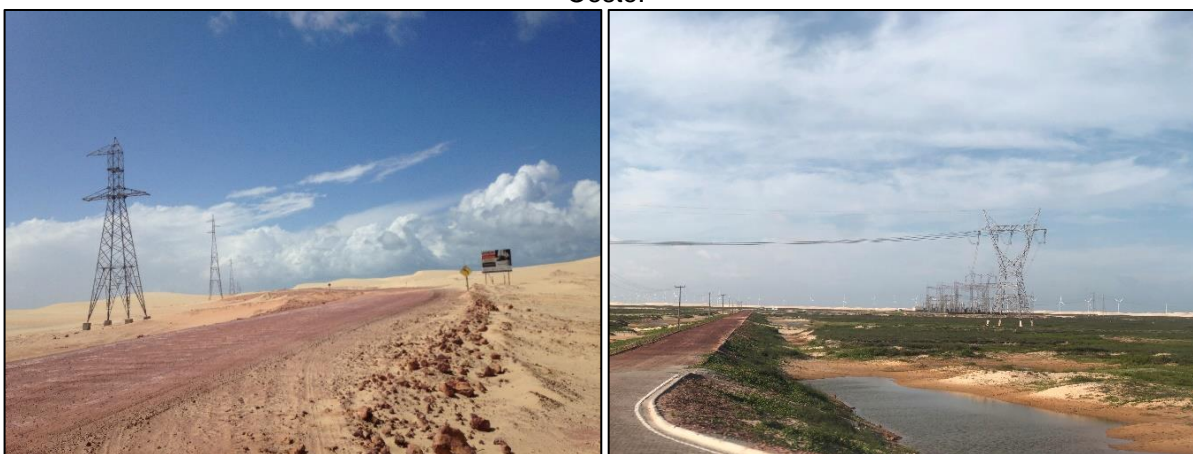
Figuras 59 e 60 – Trecho da linha de transmissão, rodagens e subestação do Complexo Eólico Oeste.
