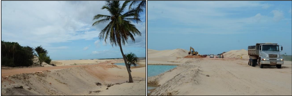
Figuras 08 e 09 – Construção da rodovia MA-315, entre os municípios de Paulino Neves e Barreirinhas, em meio a dunas moveis e lagoas interdunares.
