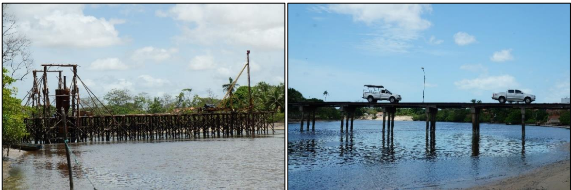
Figuras 10 e 11 – Construção da ponte de concreto no município de Paulino Neves e ponte antiga em madeira.
