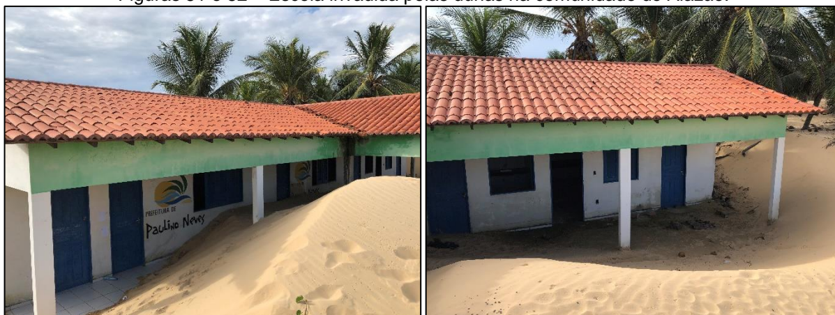
Figuras 51 e 52 – Escola invadida pelas dunas na comunidade do Alazão.
