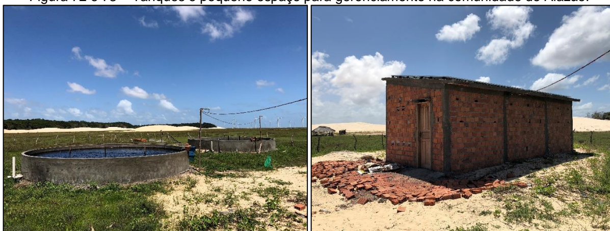
Figura 72 e 73 – Tanques e pequeno espaço para gerenciamento na comunidade do Alazão.
