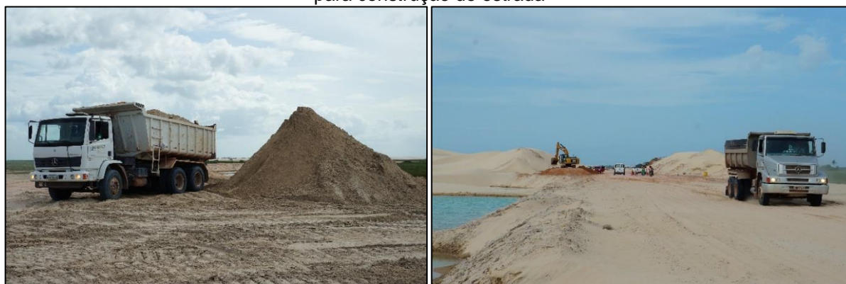
Figuras 68 e 69 – Aterramento de área de lagoas interdunar e corte realizado entre dunas e lagoas para construção de estrada
