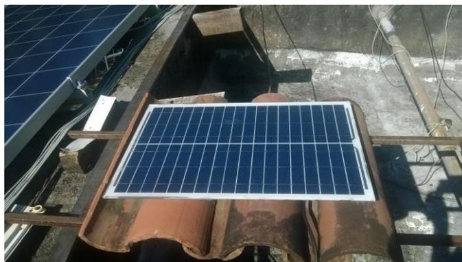
Figura 3 - Módulo modelo KS20T instalado de forma convencional em telhado no LEA/UFC.
