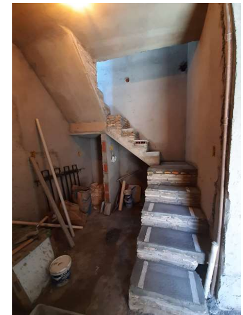
Imagem 33. Registro da execução dos degraus em tijolos maciços. Fonte: Enviado pelo Morador
