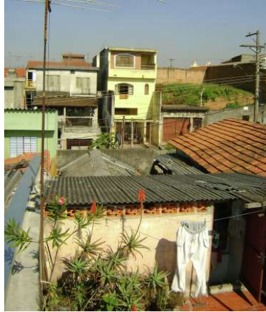
Imagem 12. Vista externa antes da reforma. Fonte: ArchDaily
