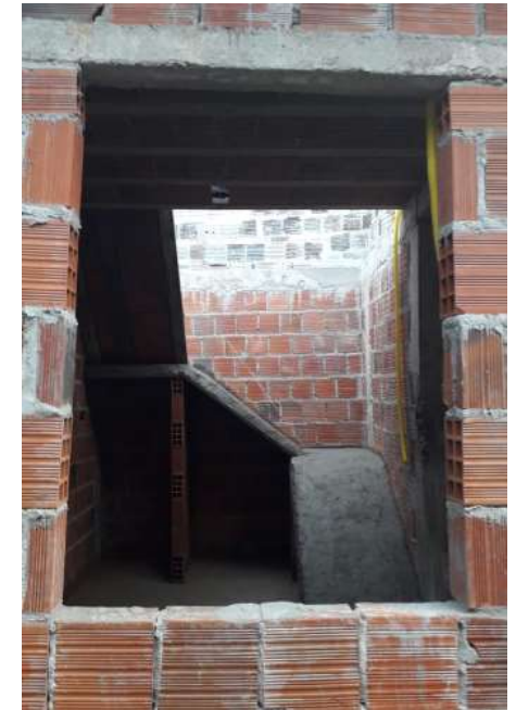
Imagem 32. Registro da execução da base de concreto e alvenaria da escada. Fonte: Enviado pelo Morador
