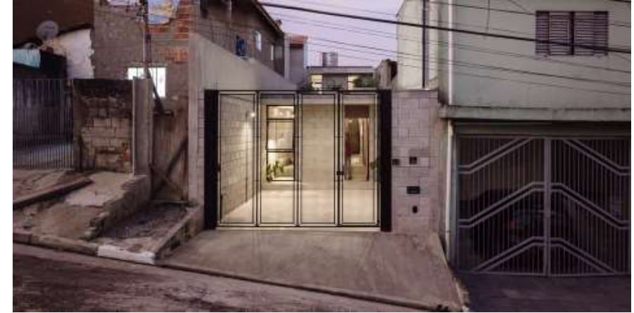
Imagem 14. Fachada depois da reforma. Fonte: ArchDaily
