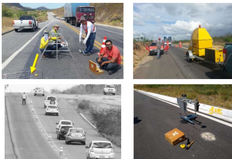
Figura 2.11 – Realização de ensaios nos trechos monitorados pelo LMP/UFC
