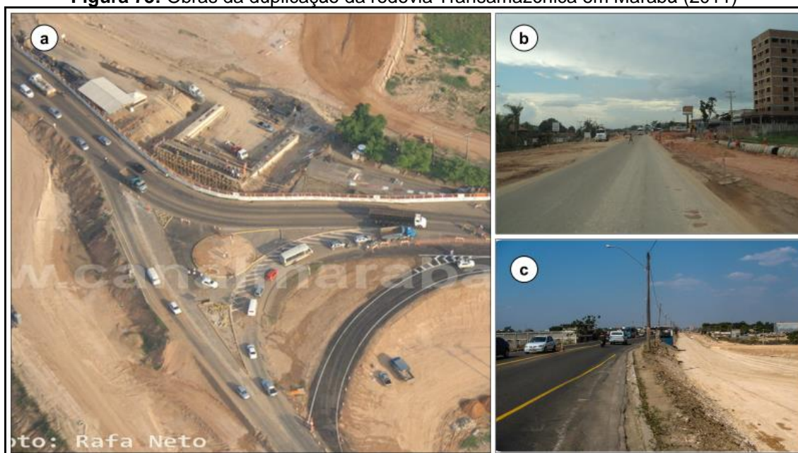
Figura 73: Obras da duplicação da rodovia Transamazônica em Marabá (2011)
