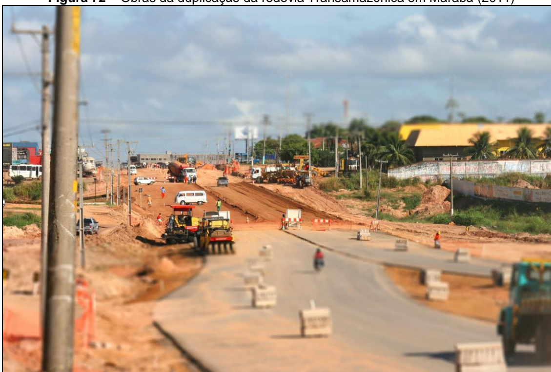
Figura 72 – Obras da duplicação da rodovia Transamazônica em Marabá (2011)
