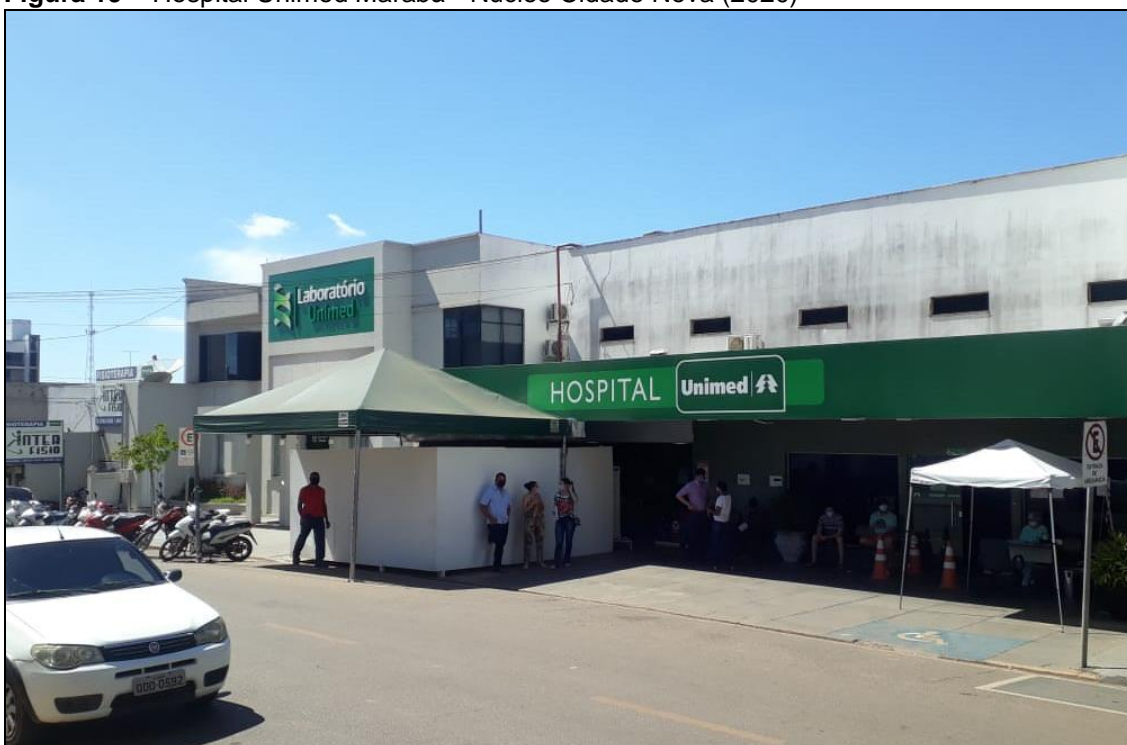
Figura 19 – Hospital Unimed Marabá - Núcleo Cidade Nova (2020)
