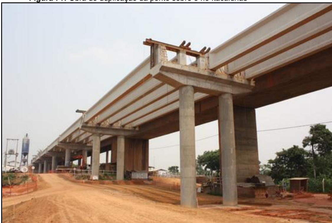
Figura 71: Obra de duplicação da ponte sobre o rio Itacaiúnas
