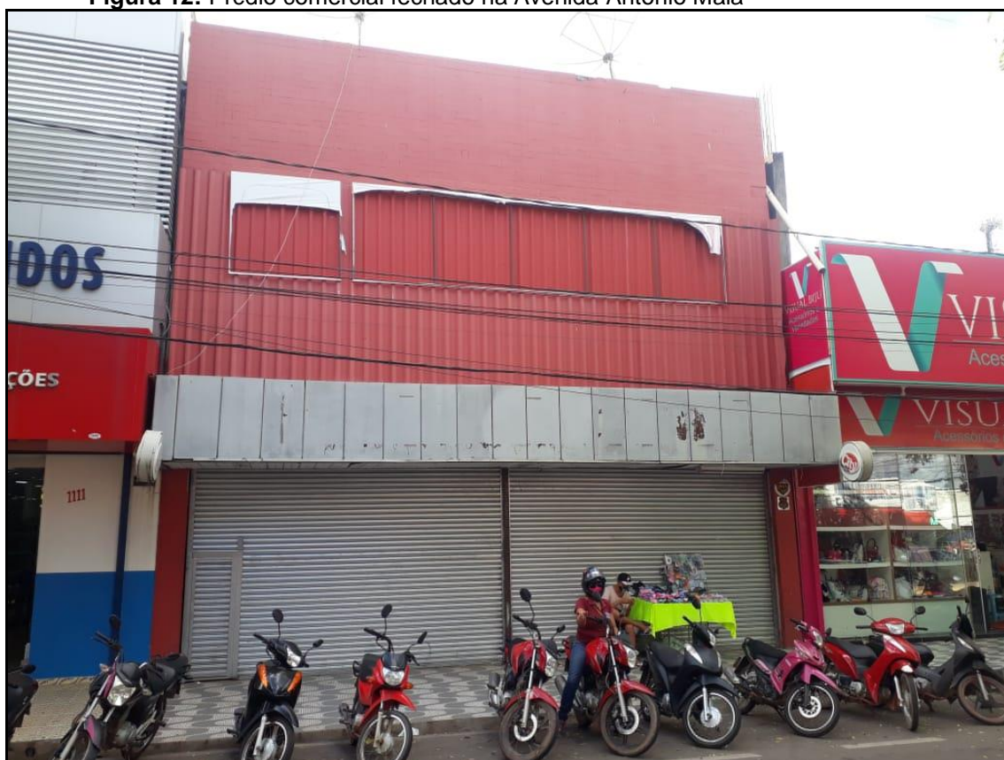
Figura 12: Prédio comercial fechado na Avenida Antonio Maia
