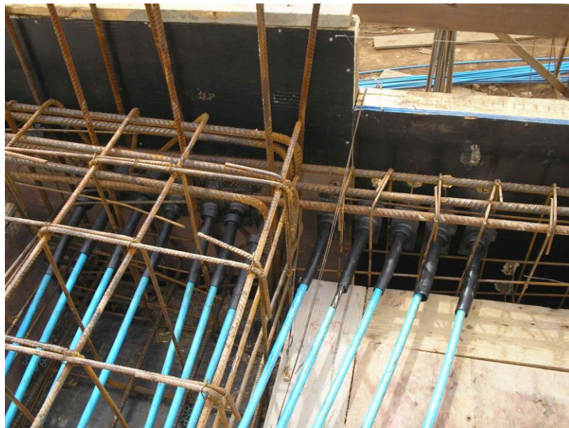
Figura 6 - Zona de ancoragem de protensão não aderente.
