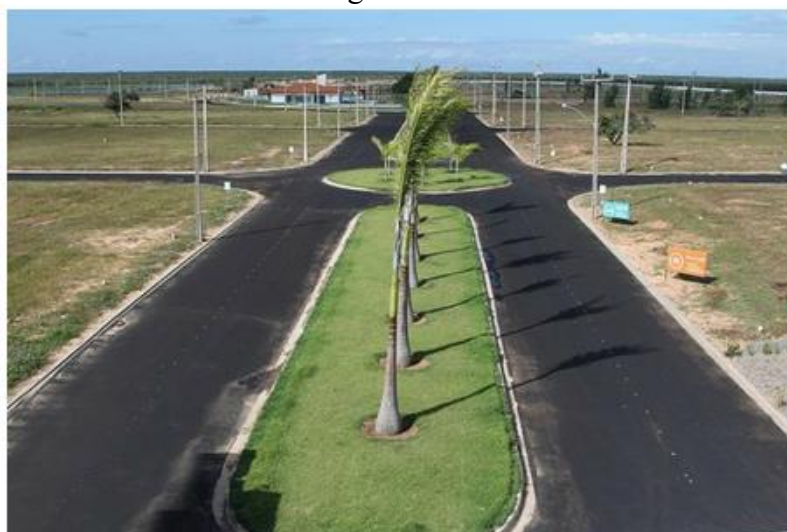
Figura 16 – Loteamentos localizados a margem da BR-343 sentido a Luís Correia
