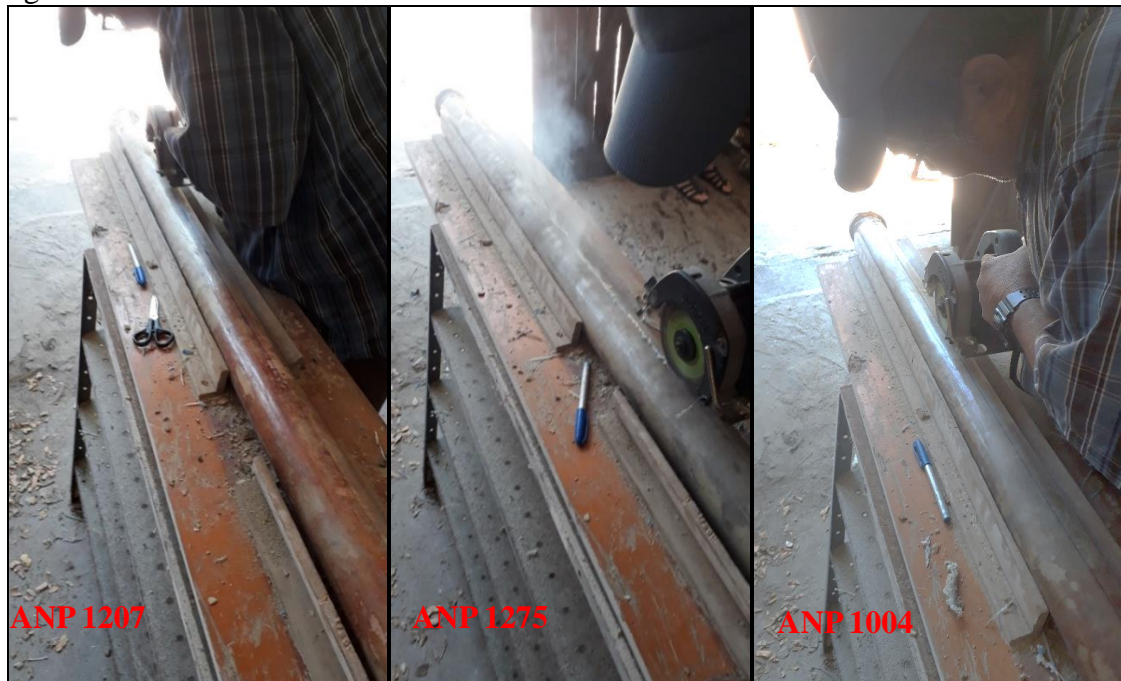
Figura 11- Abertura dos liner
