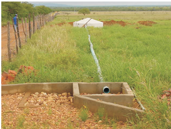
Figura 3.11 Cisterna construída com o objetivo de suprir de água os animais
