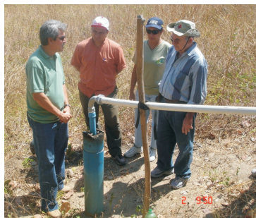
Figura 4.11 Poço tubular raso construído no neossolo
