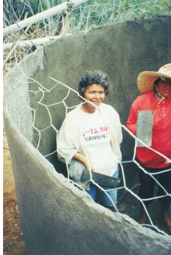
Figura 11.17 Construção de cisterna de concreto com tela de arame
