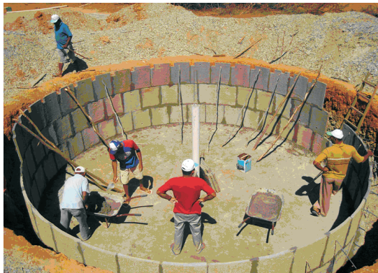
Figura 11.19 Construção de cisterna para a produção de verduras e fruteiras
