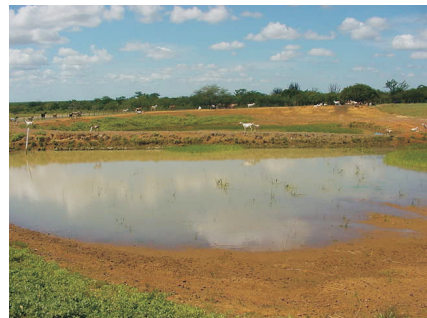
Figura 3.12 Barreiro para irrigação de salvação contendo áreas de captação e de plantio
