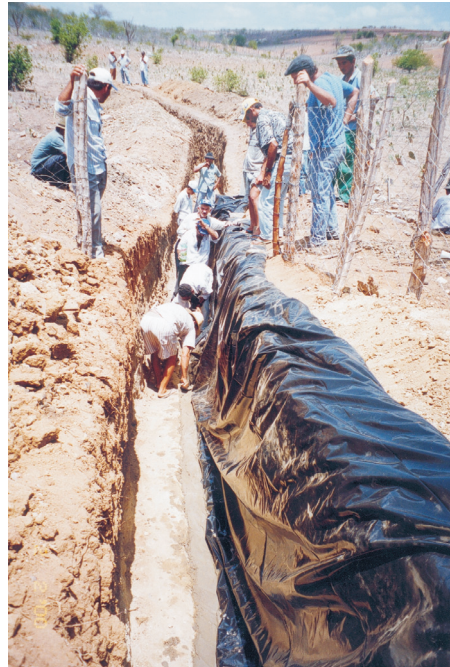
Figura 11.21 Barragem subterrânea, colocando a lona de PVC
