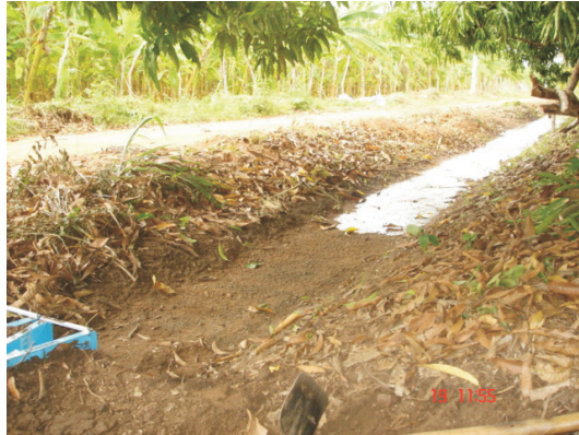
Figura 4.7 Calhas Parshall para obtenção das hidrógrafas de vazão
