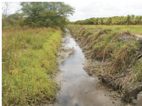
Figura 4.12 Dreno coletor que recebe excedente de água da irrigação por sulcos
