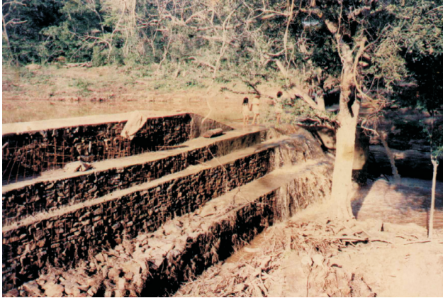
Figura 11.26 Barragem de gabião
