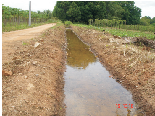
Figura 4.8 Canal secundário não revestido
