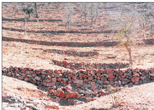
Figura 11.9 Terraçamentos e barramentos de voçoroca em Gujarat, Índia
