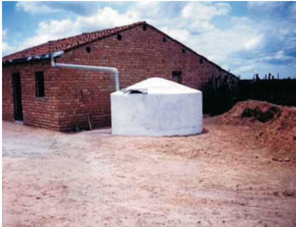
Figura 3.9 Cisterna tipo placa construída no semiárido brasileiro
