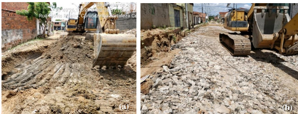
Figura 1: (a) Terreno escavado e (b) Pedra rachão de RCD lançada na via
