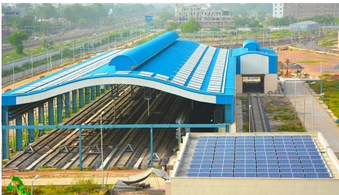
Figura 11 - Prédio da companhia DMRC com instalação de módulos FV no teto
