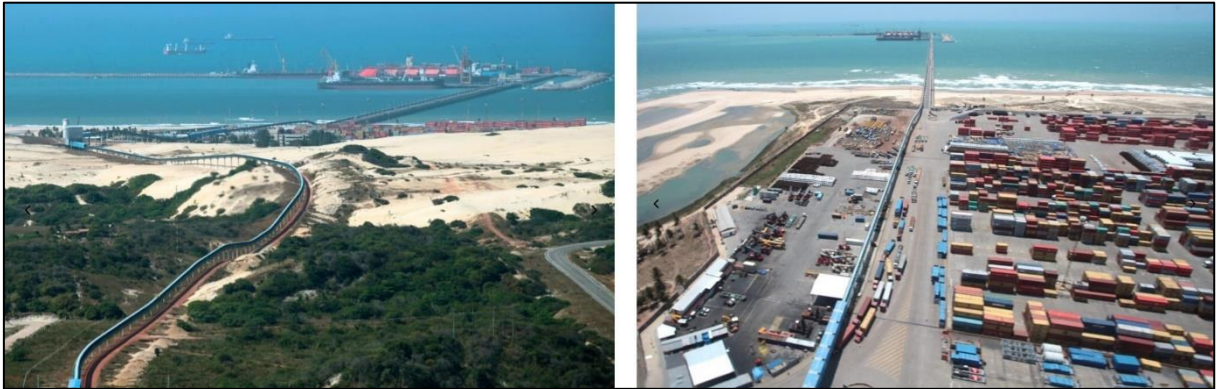
Figura 7 – Terminal Portuário do Pecém.
