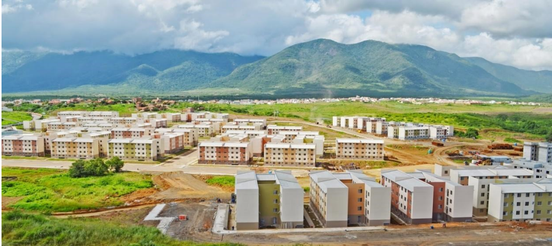
Figura 1 – Fotografia do Residencial Nova Caiçara
