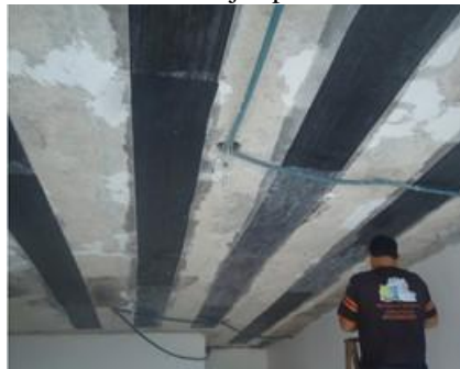
Figura 5 – Fibras de carbono em laje aplicada de forma unidimensional
