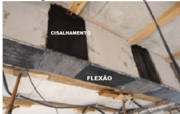
Figura 4 – Fibras de carbono na viga
