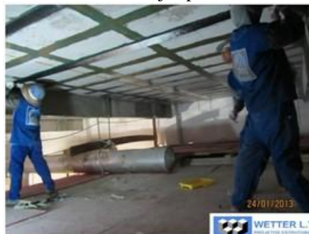
Figura 6 – Fibras de carbono em laje aplicada de forma bidimensional
