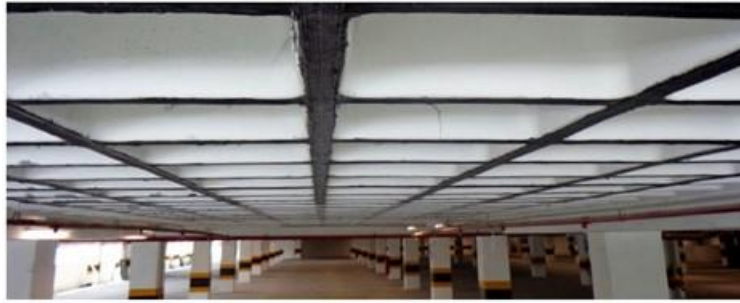
Figura 7 – Fibras de carbono aplicadas em laje nervurada
