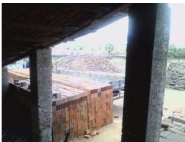
Figura 03- Resíduos (caco de tijolos queimados),estoque de lenha, produtos acabados no pátio e construção de casas próximo ao muro da cerâmica. Fonte própria, 2011
