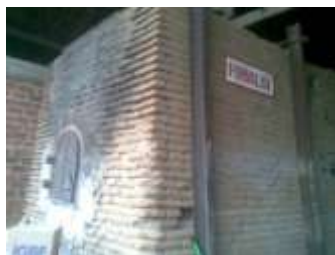
Figura 15- Fornalha de um forno amarrada com trilhos. Fonte própria, 2010.
