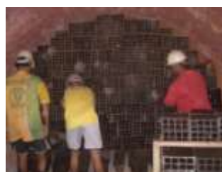
Figura 06- Colocação dos tijolos sem automação. Fonte própria, 2009.
