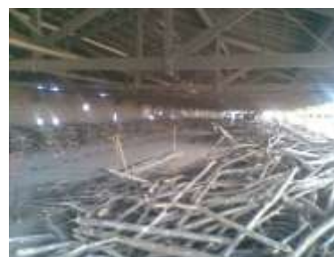
Figura 11-Grande quantidade de lenha jogada em sobre um forno Hoffman no município de Sobral. Fonte própria, 2011.
