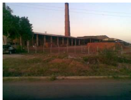
Figura 14 - Município de Chorozinho, forno Hoffman onde a chaminé tem um formato igual à chaminé do forno Paulistinha. Fonte própria, 2011.
