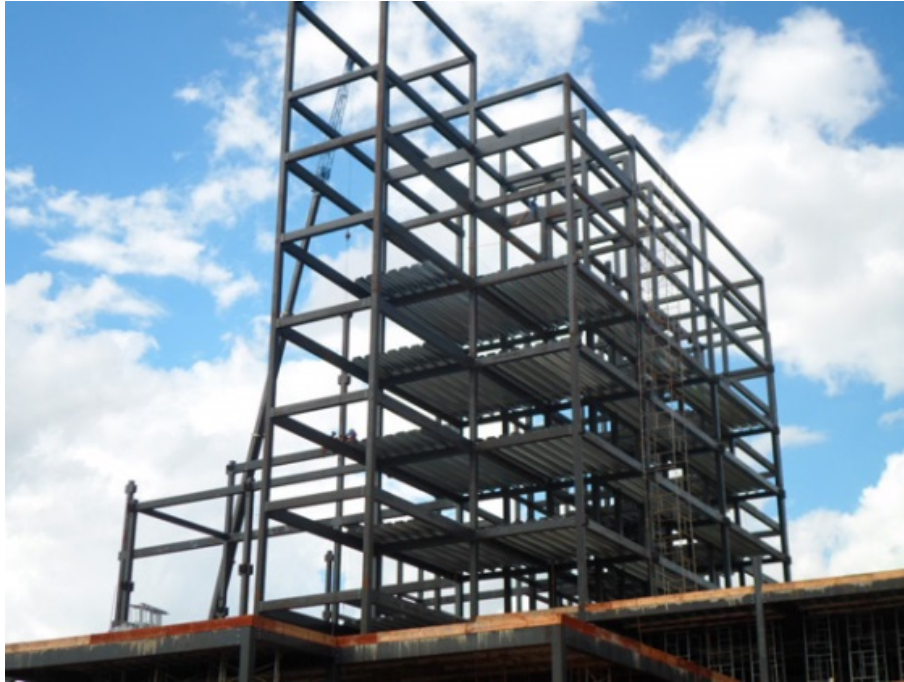
Figura 1 – Estrutura metálica pré-moldada
