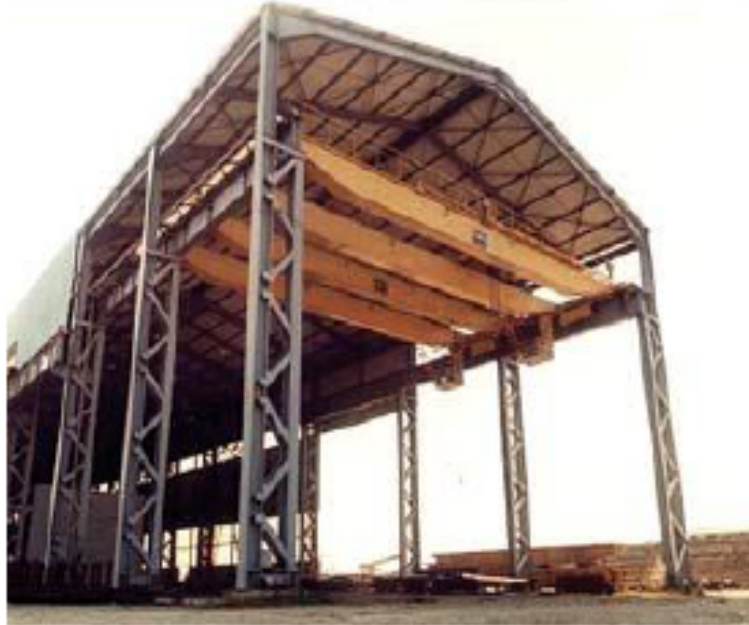
Figura 16 – Pórticos com colunas treliçadas
