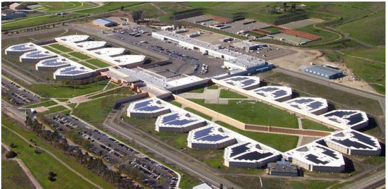
Figura 11 - MR da prisão de Santa Rita, nos Estados Unidos, com destaque para os módulos FV instalados (à esquerda) e a planta de CaC (à direita)
