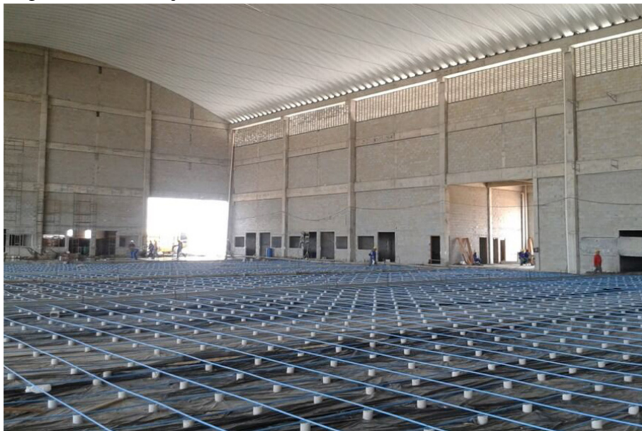
Figura 3 – Fundação em radier.
