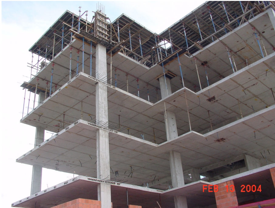
Figura 2 – Edifício residencial Oren.
