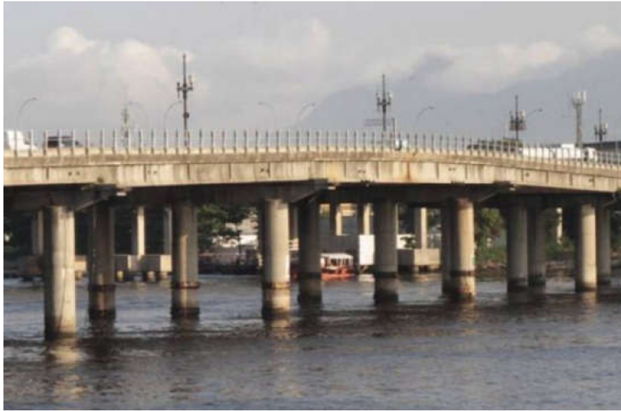
Figura 1 – Ponte do Galeão.
