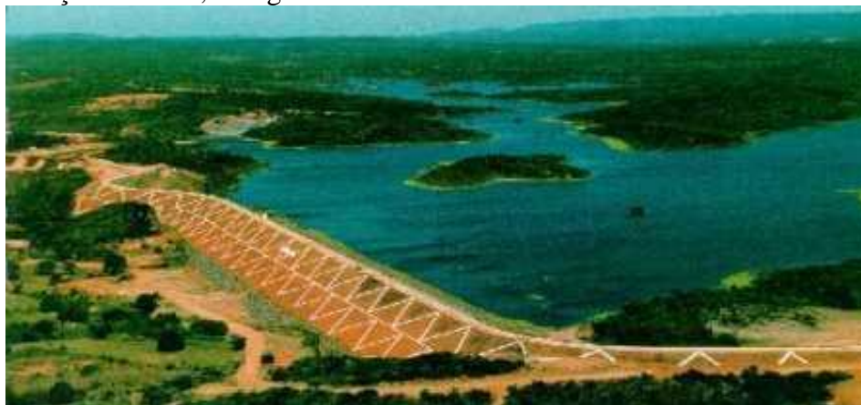
Figura 19 – Foto panorâmica do barramento e de parte do espelho d'água do açude Trussu, em Iguatu/Ce
