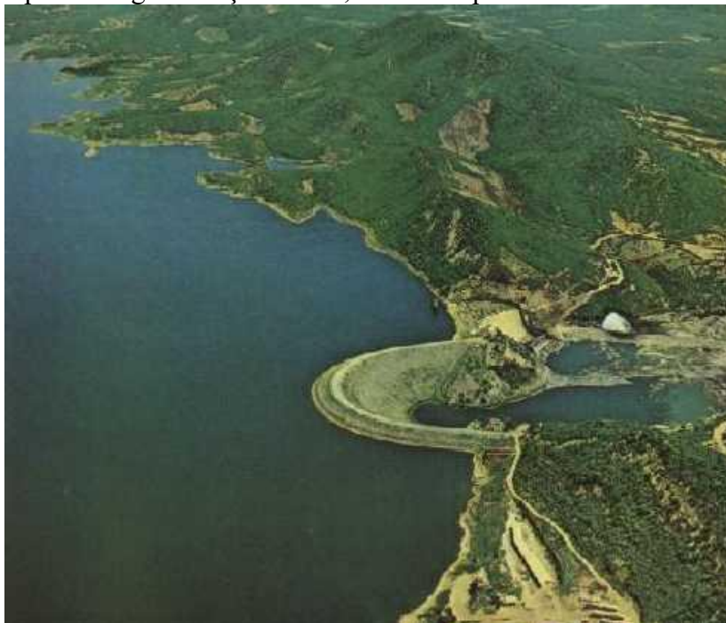
Figura 18 – Foto panorâmica do barramento e de parte do espelho d'água do açude Orós, no município de Orós/Ce
