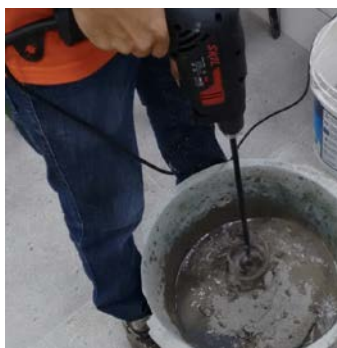
Figura 1 - Processo de preparo do concreto
