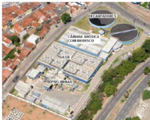
Figura 1: Estação de tratamento de Efluentes Dom Nivaldo Monte, ETE-Baldo.
