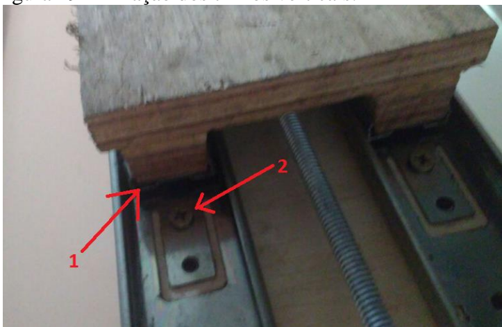
Figura 19 – Fixação dos trilhos verticais.
