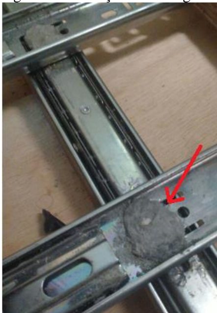
Figura 20 – Fixação entre as guias horizontais.
