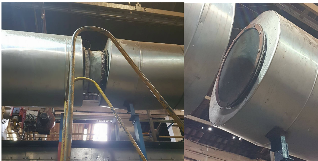
Imagem 2 - Junta de Expansão Antes e Depois
