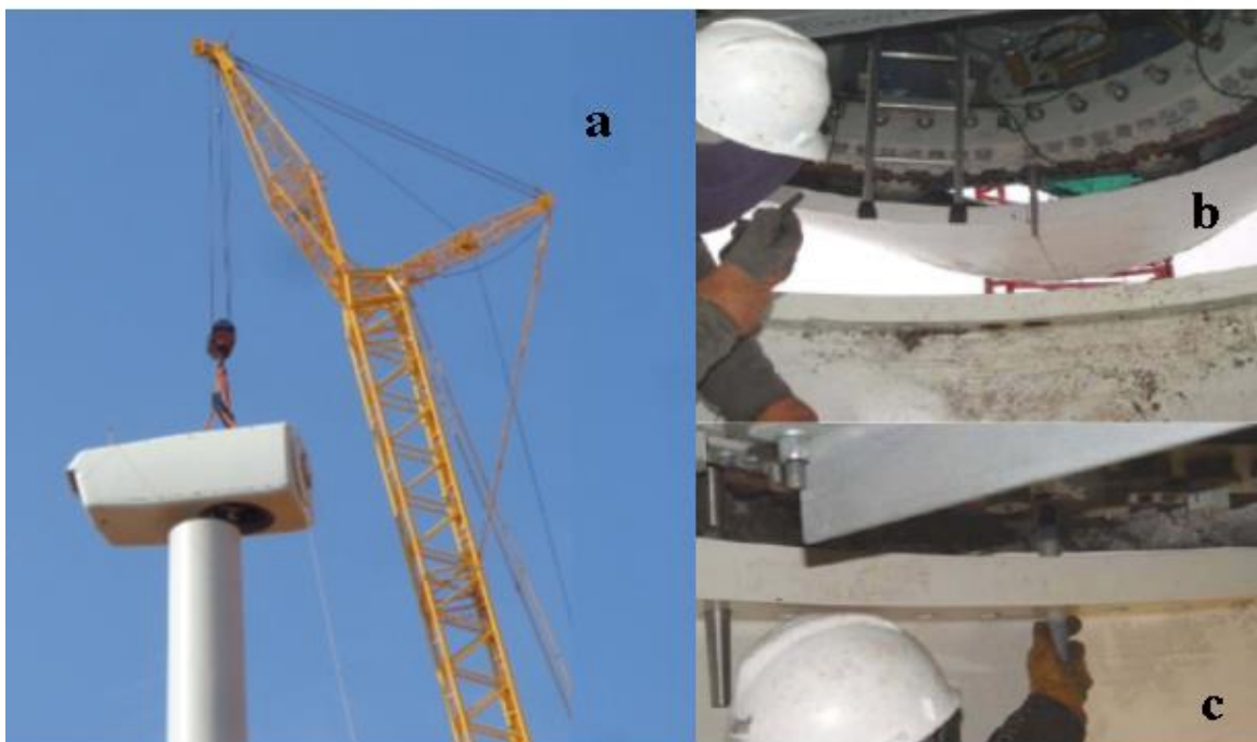
Figura 24 - Montagem da Nacelle no segmento do topo T3
