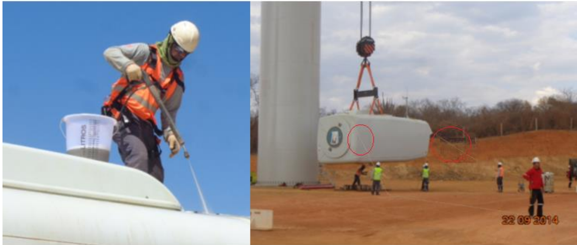
Figura 23 - Preparação da Nacelle para o içamento
