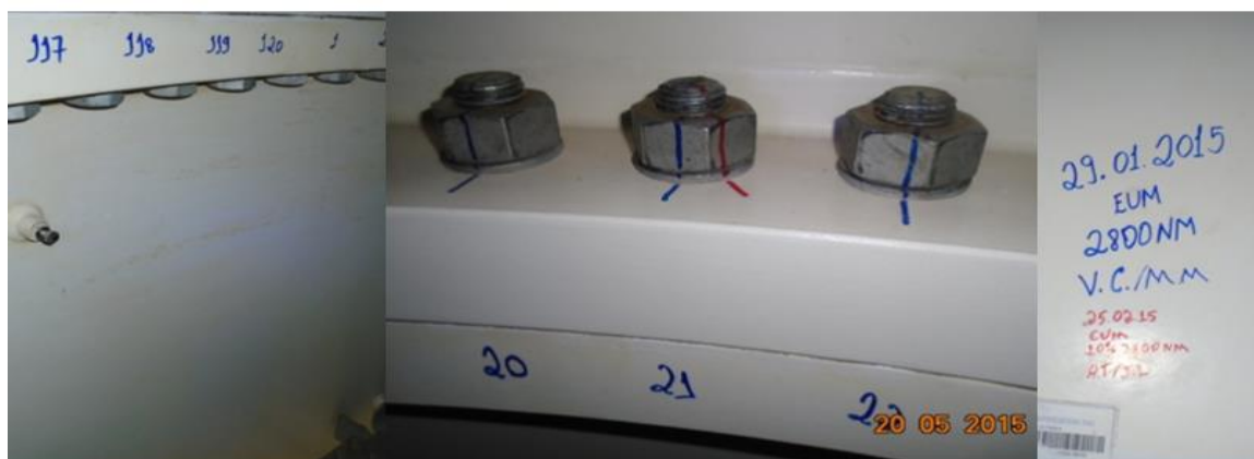
Figura 17 - Exemplo de indicação de torque realizado numa união de segmentos
