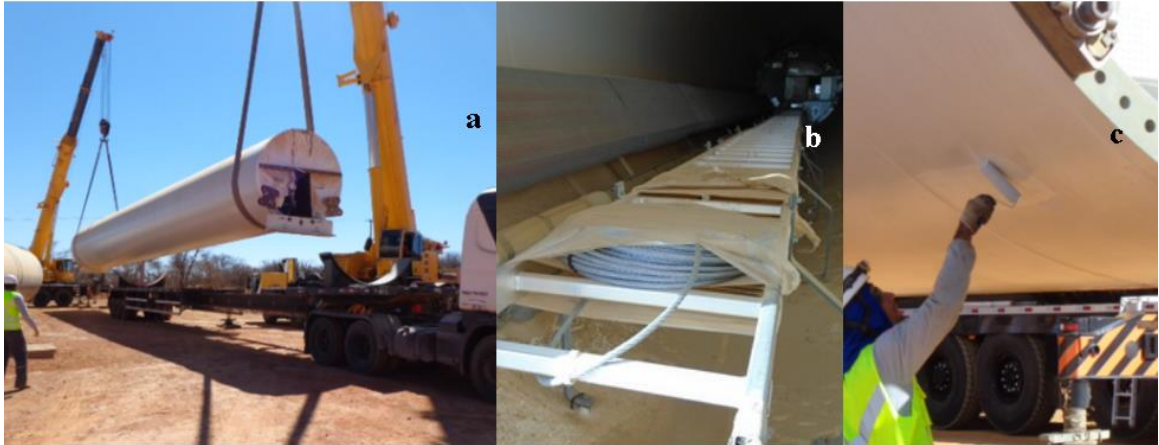
Figura 8 - Recebimento e preparação de segmentos de torre
