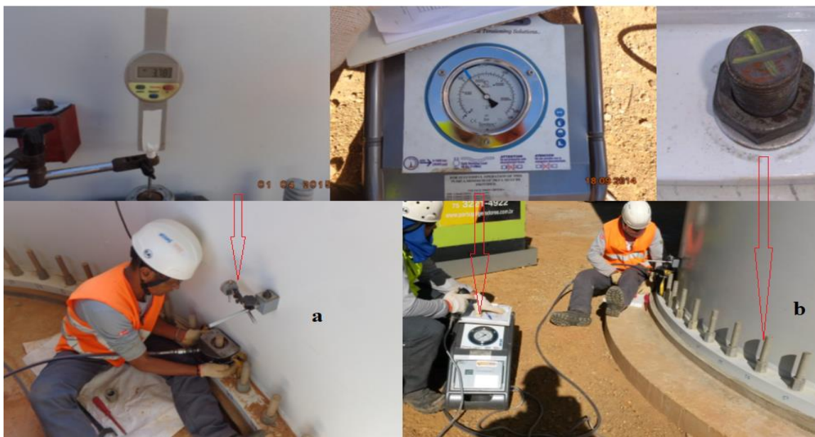
Figura 16 - Exemplo de procedimento de tensionamento
