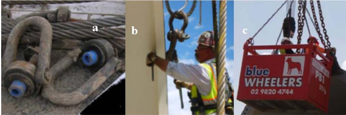
Figura 11 - Colocação de acessórios de içamento para segmentos de torre
