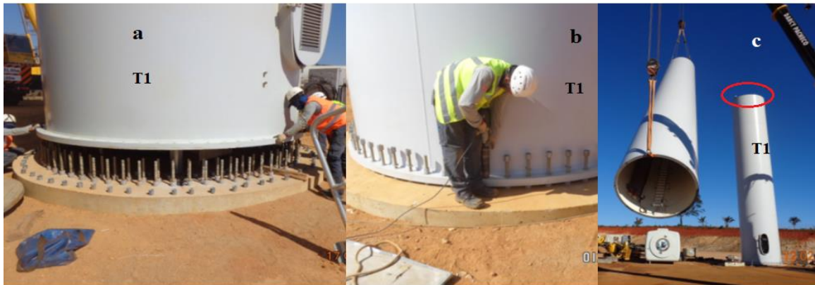
Figura 13 - Montagem do segmento da base T1
