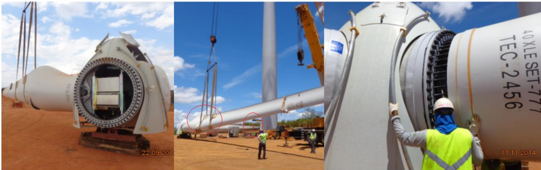
Figura 34 - Pré-montagem do Rotor
