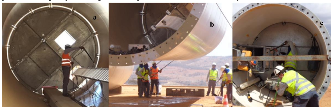
Figura 10 - Preparação e limpeza de segmentos de torre antes do içamento
