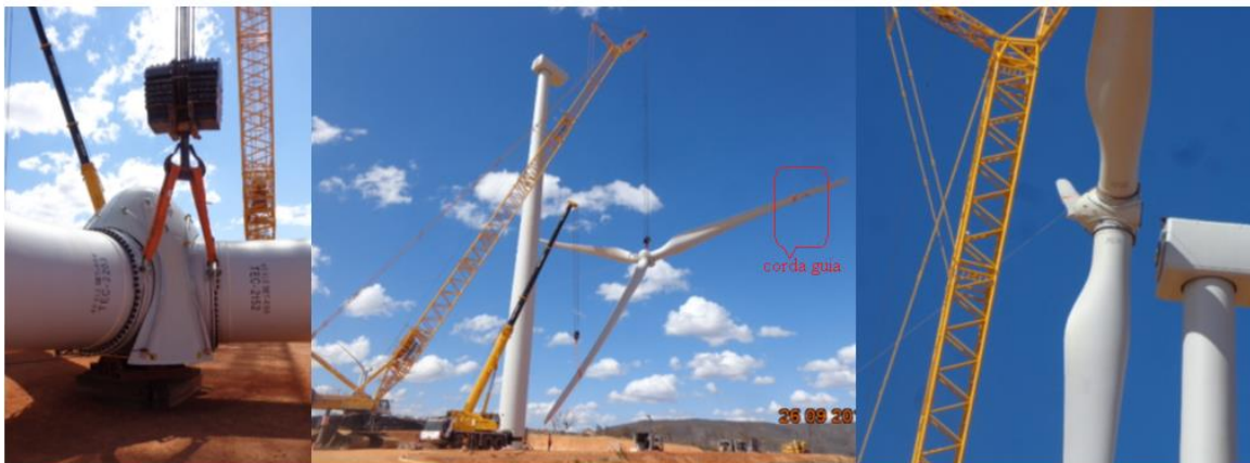
Figura 36 - Içamento do Rotor
