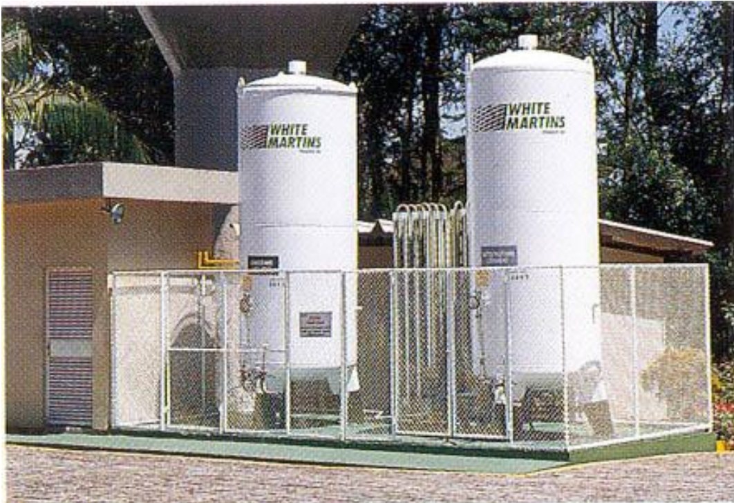
Figura 20 – Instalação padrão de ar medicinal sintético
