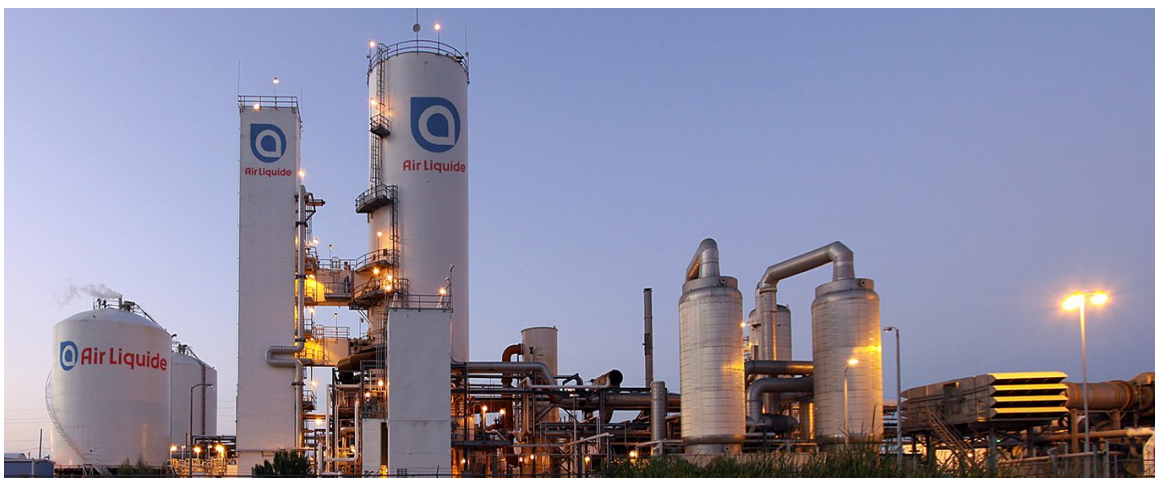
Figura 08-Planta de destilação criogênica, fornecimento on- site
