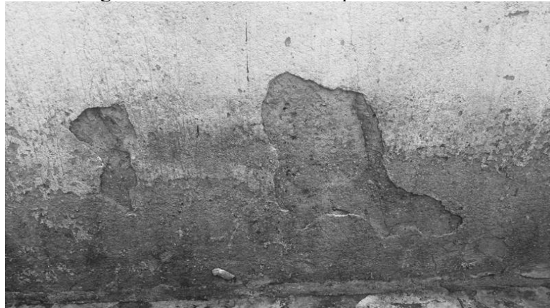
Figura 7 - Descolamento em placa endurecida.
