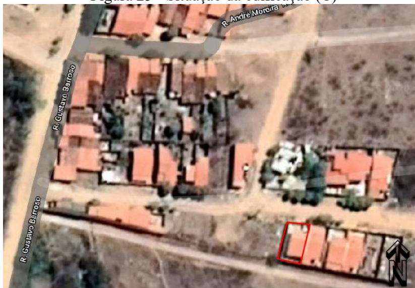
Figura 25 - Situação da edificação (C)
