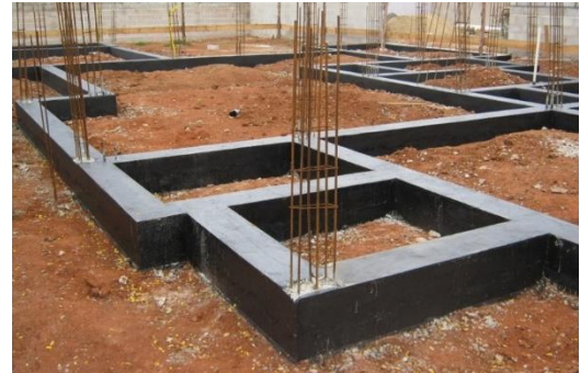
Figura 28 - Impermeabilização da viga baldrame com tinta asfáltica
