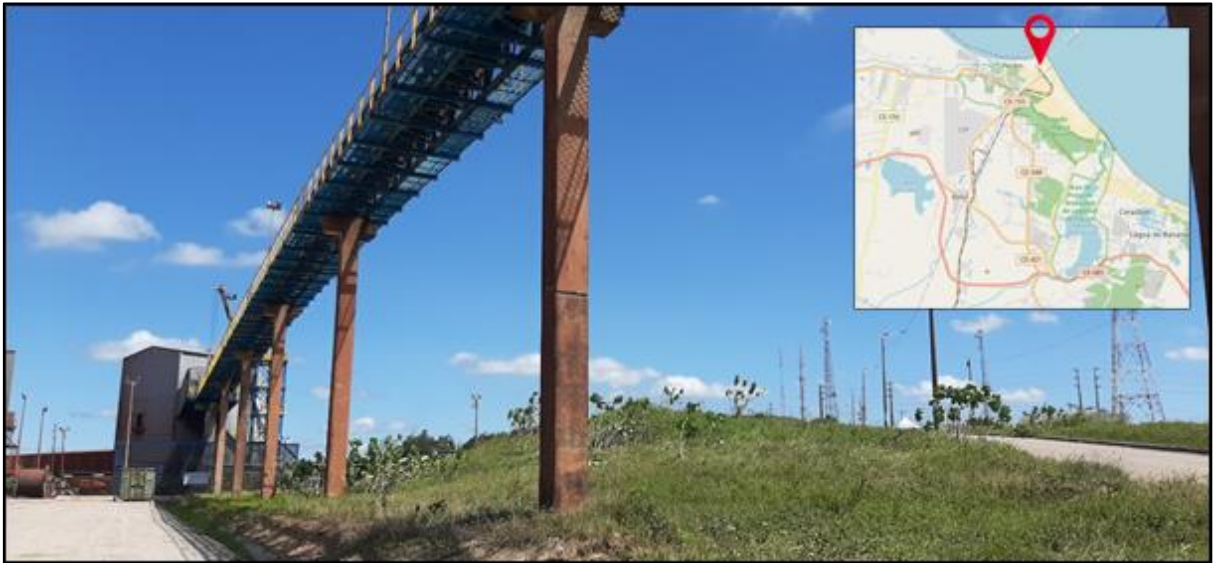
Figura 22 – Esteira transportadora de minério de ferro e carvão que liga o Porto do Pecém e o CIPP
