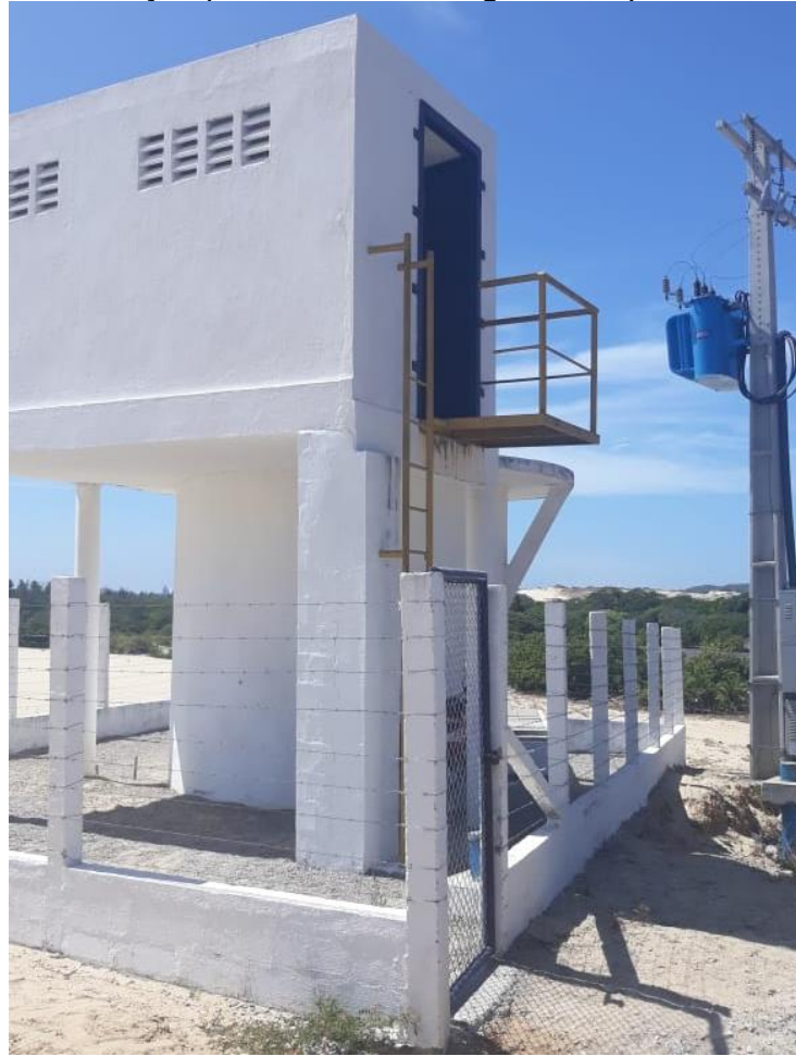
Figura 26 – Poços para retirada de água do aquífero livre dunar
