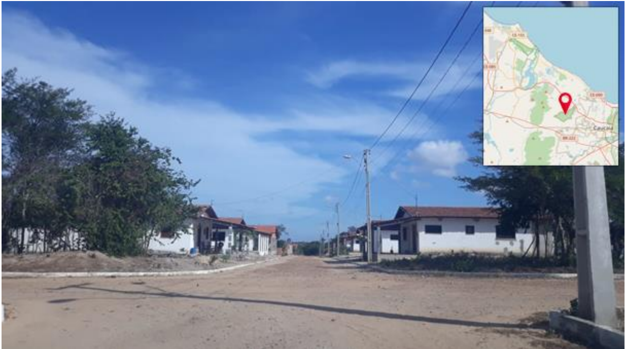
Figura 3 – Vilas de casas de reassentamento na Reserva Indígena Taba dos Anacé
