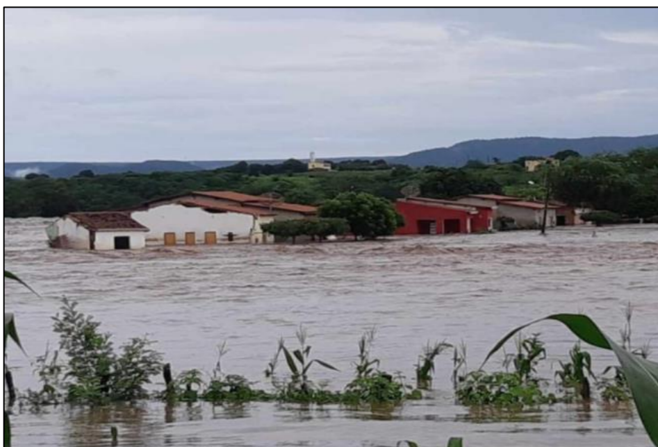
Figura 24 – Localidade atingida pelo rompimento da barragem do Açude Pontal
