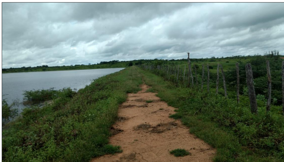
Figura 10 - Barragem do Açude São Francisco, Crateús - CE
