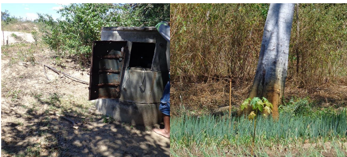
Figura 43 - Árvore manchada por água férrica do poço F8, PICP-CE.
