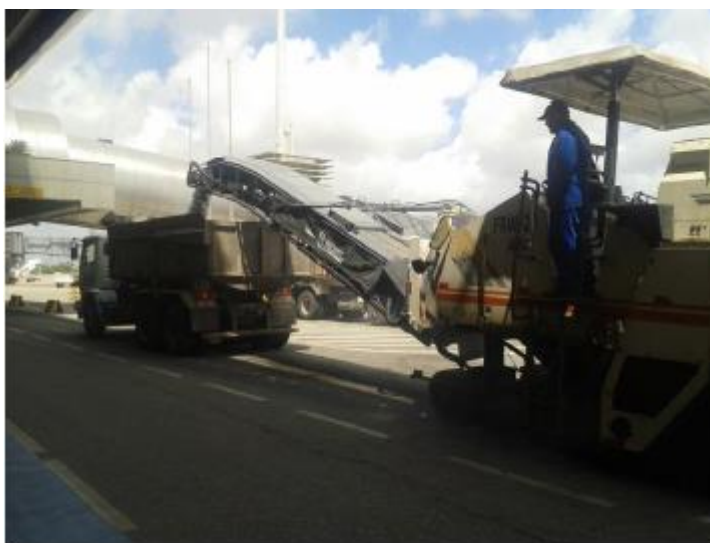
Figura 1 - Realização de fresagem em trecho em obra
