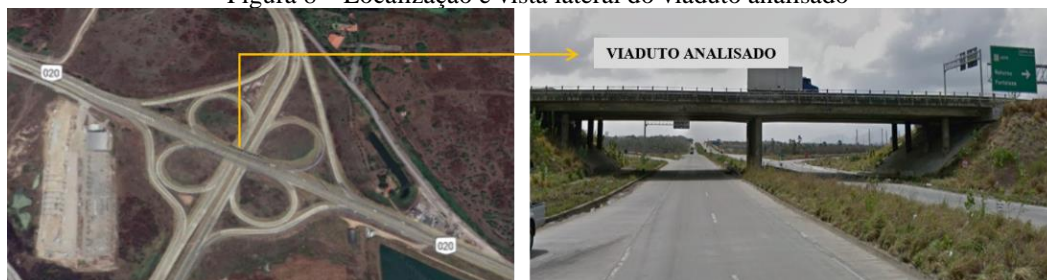
Figura 8 – Localização e vista lateral do viaduto analisado
