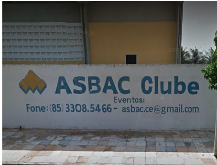
Figura 2 - Fachada do Clube da ASBAC
