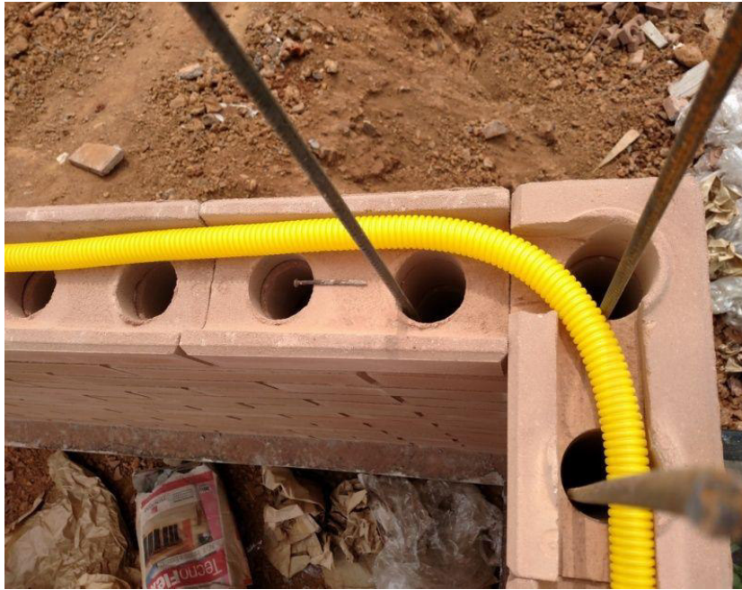
Figura 12 - Instalação Elétrica em Blocos Ecológicos
