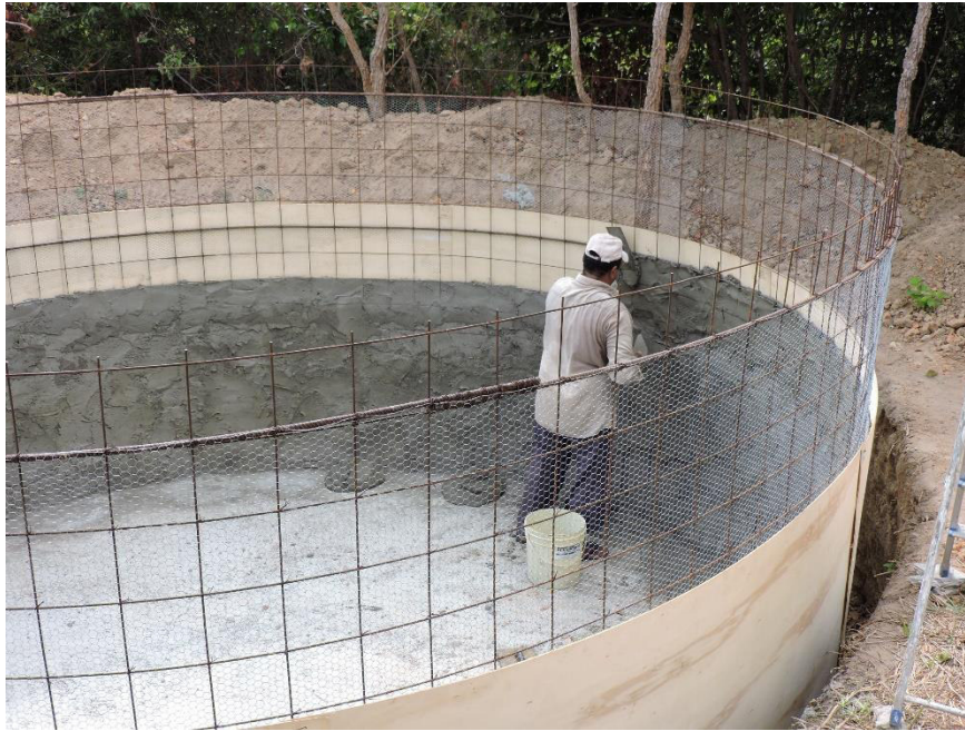
Figura 9 - Construção de cisterna ferrocimento
