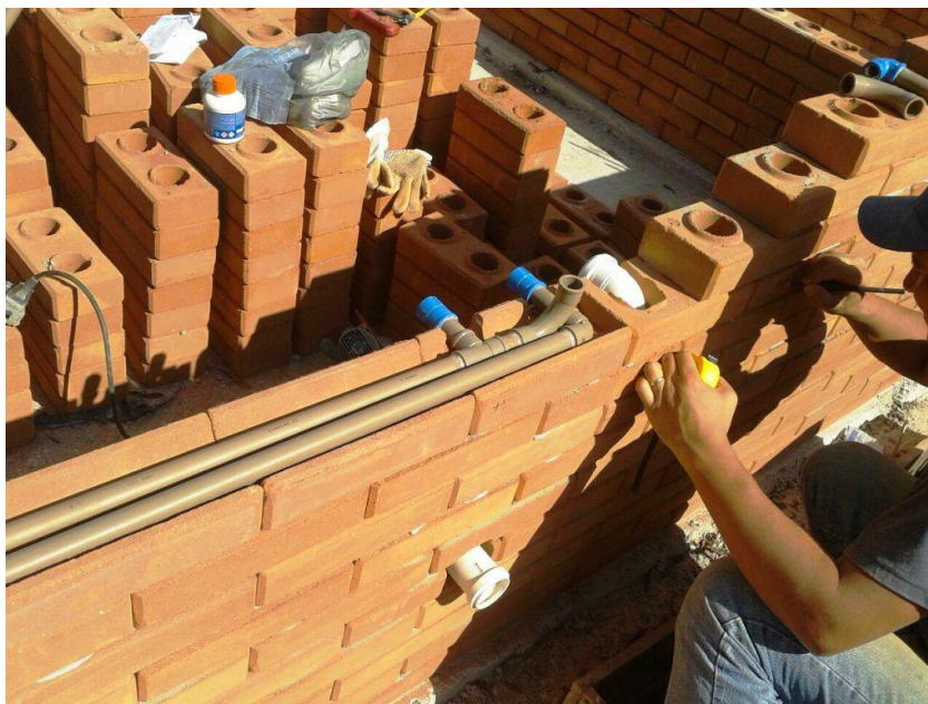
Figura 13 - Instalações Hidráulicas em Blocos Ecológicos
