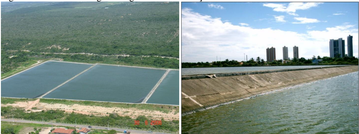
Figura 4 - ETE Ponta Negra - Lagoas de Estabilização
