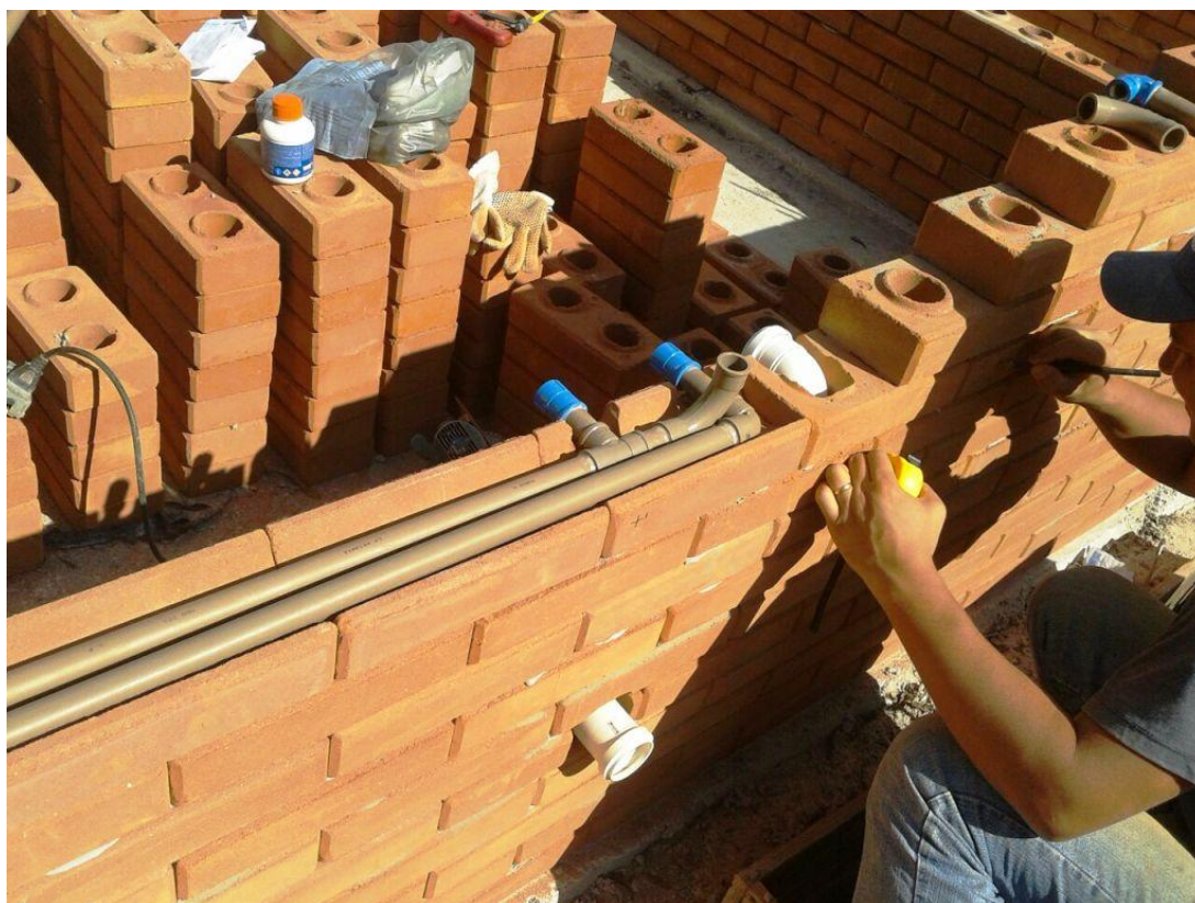
Figura 6 - Blocos especiais com passagem para tubulações
