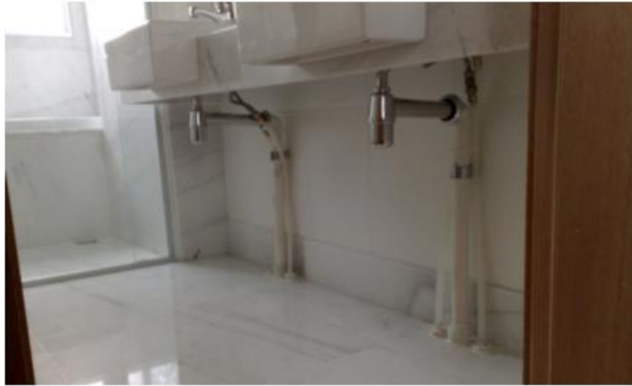
Figura 14 - Instalação de esgoto e água aparente
