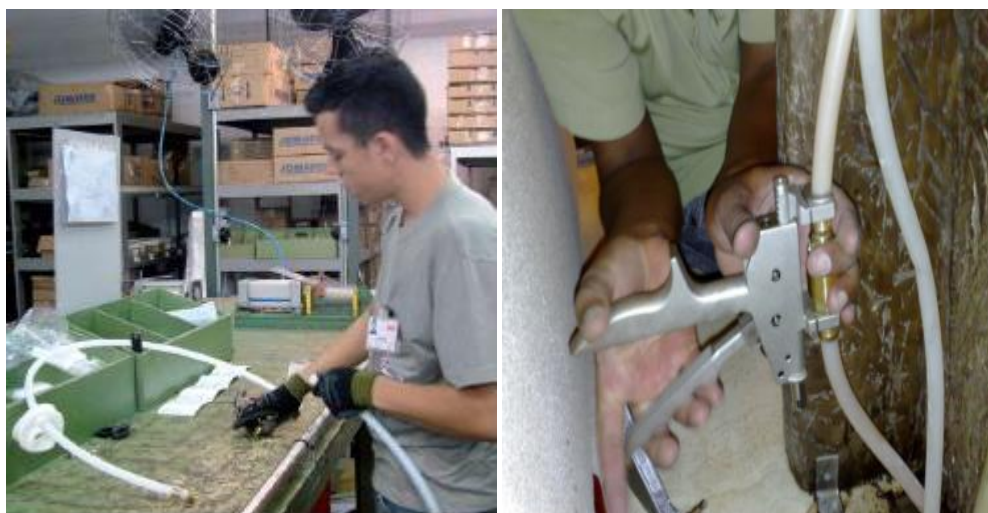
Figura 11 - Instalação do PEX
