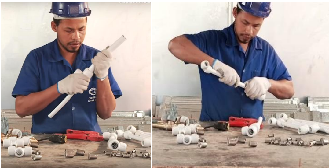
Figura 19 - Engate rápido tipo Push fit
