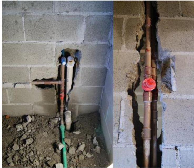
Figura 1 - Execução de instalações no sistema construtivo tradicional
