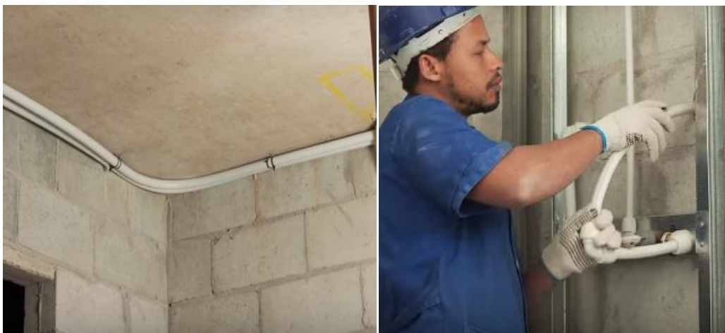
Figura 22 - Flexibilidade dos tubos
