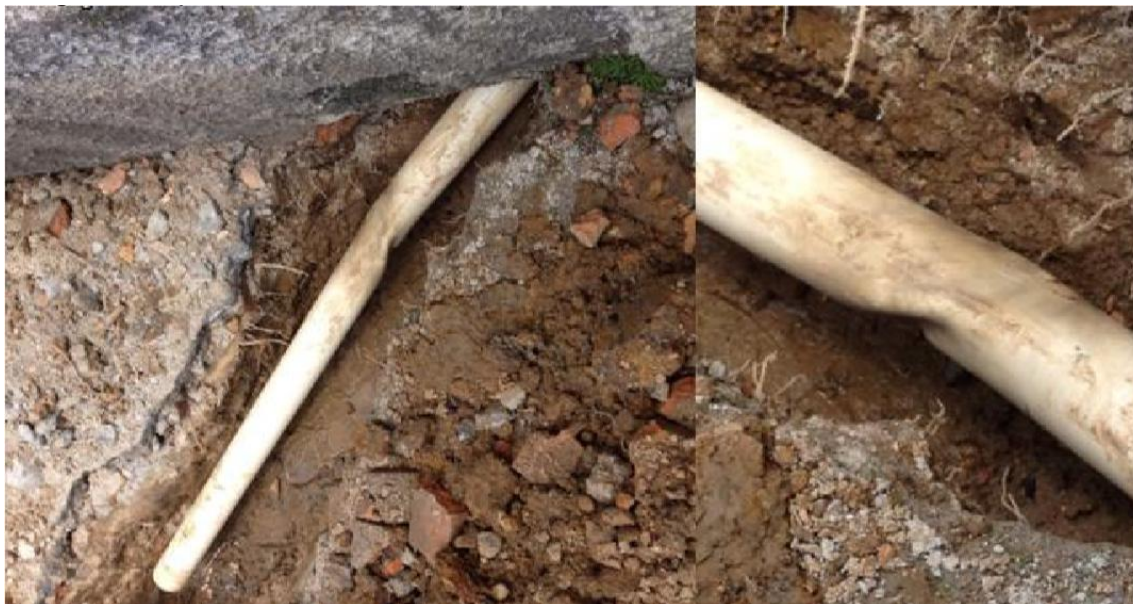
Figura 10 - Aquecimento de tubulações
