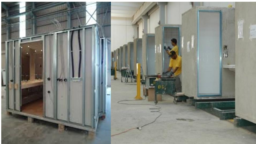
Figura 17 - Detalhe dos banheiros prontos
