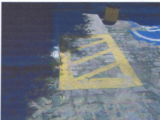
Fig. 09. Observe-se o cesto de lixo, obstruindo a vaga de estacionamento destinada ao portador de necessidades especiais, além do piso ser totalmente inadequado para o usuário de cadeira de rodas.
