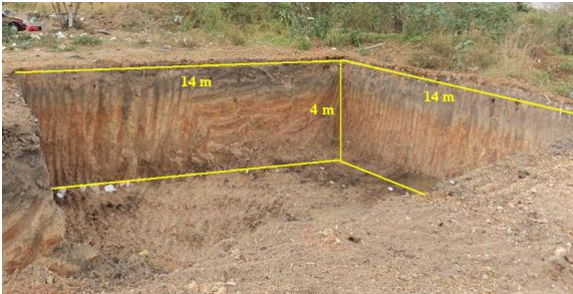
Figura 8 - Vista parcial da CE aberta, 2011
