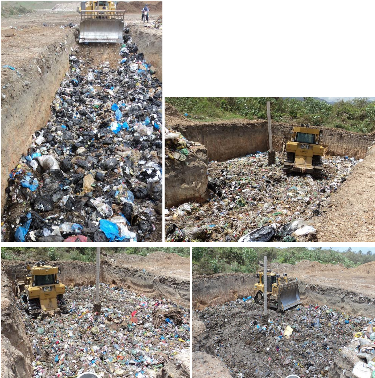
Figura 23 - Vista da CE em preenchimento e do trator de esteiras, 2011
