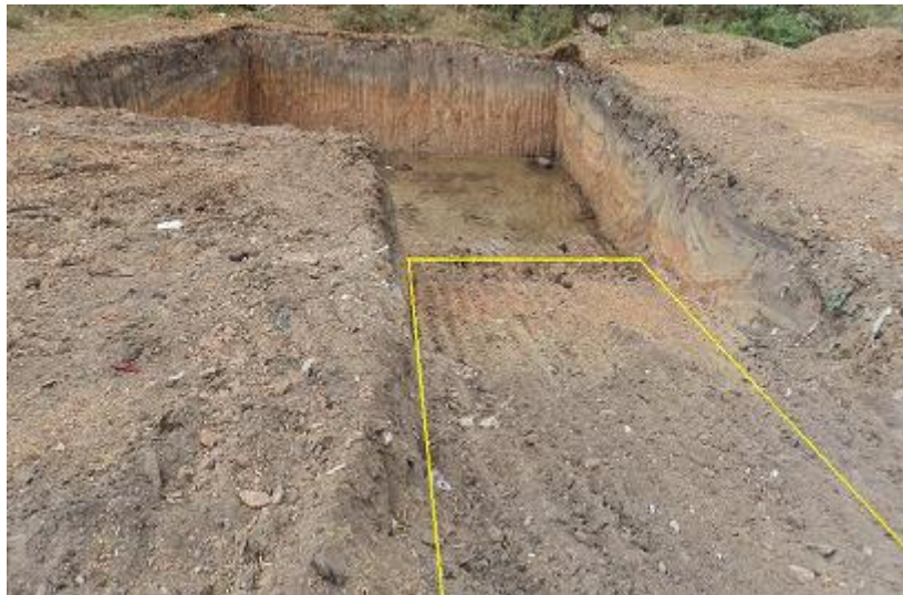
Figura 9 - Vista da rampa externa de acesso a CE, 2011
