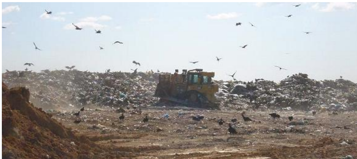
Figura 4 - Vista geral da frente de serviços do ASMOC, 2011
