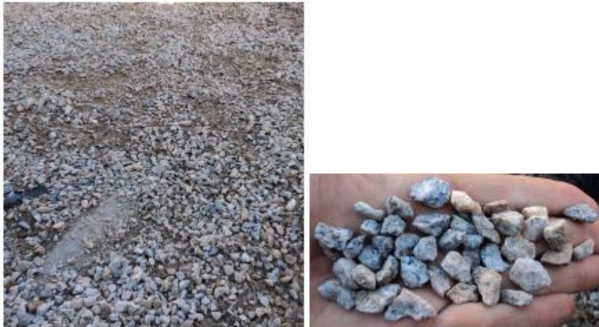
Figura 16 - Vista parcial da camada drenante e dos pedriscos, 2011
