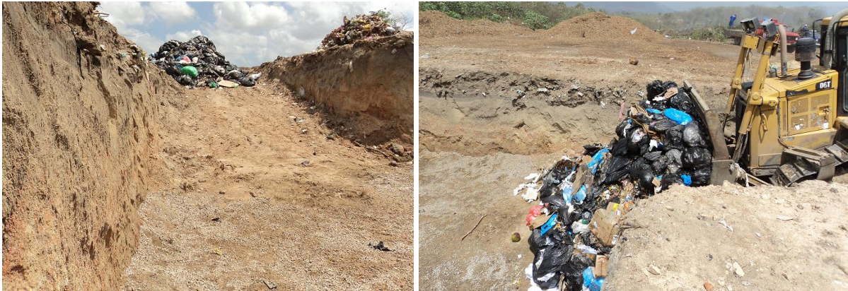
Figura 22 - Vista dos RSU na rampa de acesso a CE e entrada do trator de esteiras, 2011
