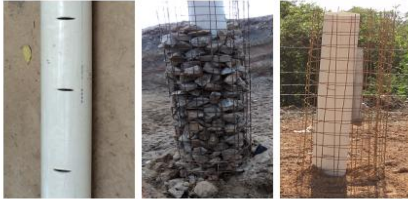
Figura 15 - Vista parcial do PVC perfurado e do dreno vertical da CE, 2011
