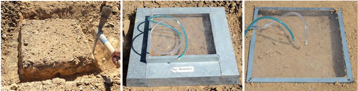
Figura 27 - Vista do processo de cravação da placa na camada de cobertura da CE, 2011
