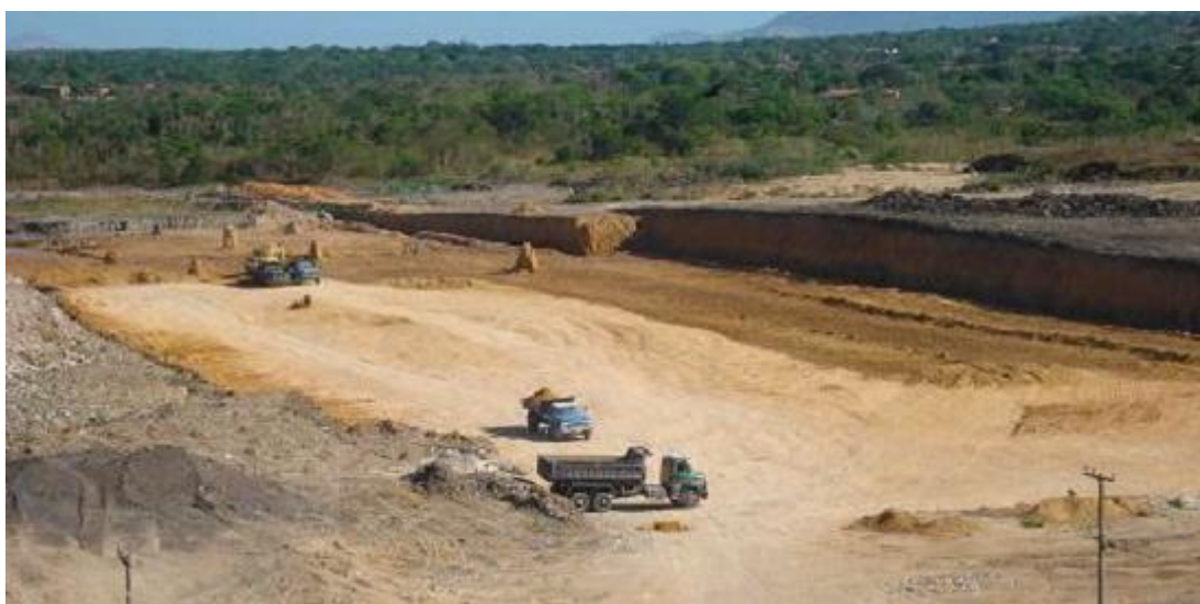
Figura 5 - Vista parcial da preparação da última trincheira do ASMOC, 2011
