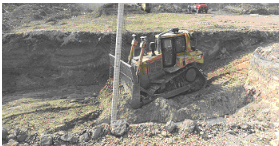
Figura 10 - Trator de esteiras descendo a rampa para nivelamento da base da CE, 2011
