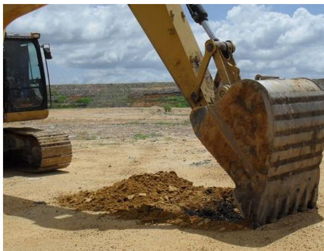
Figura 7 - Vista do processo de abertura da CE com a escavadeira hidráulica, 2011
