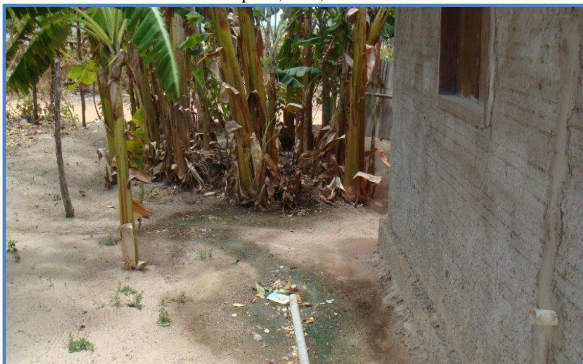
Figura 3.22 – Reúso informal das águas cinza em residência na comunidade Vila Tomé, Aquiraz, – CE, 2009.
