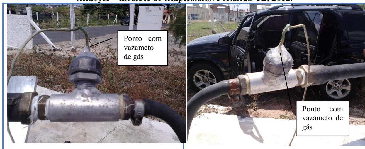
Figura 3.38 – Pontos de vazamento e perda de pressão no sistema (orifício de inserção do termopar – medidor de temperatura). Fortaleza-CE, 2012.
