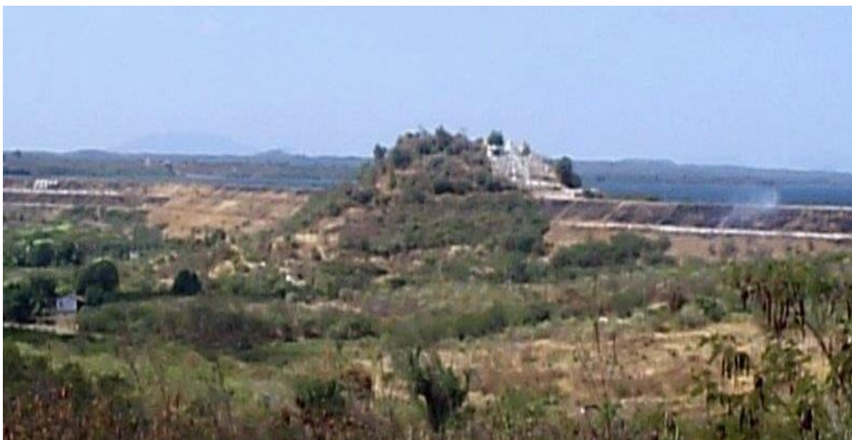
Figura 9: Morro aproveitado na estrutura da barragem do Açude Araras.
