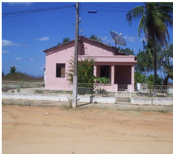
Figura 16: Aspecto de uma casa geminada construída de alvenaria no acampamento do Açude Araras para abrigar pessoal técnico.
