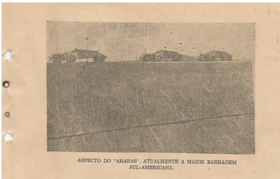
Figura 12: Perfil da barragem principal do Açude Araras com trânsito de “Trucks”, máquinas de descarregar barro.
