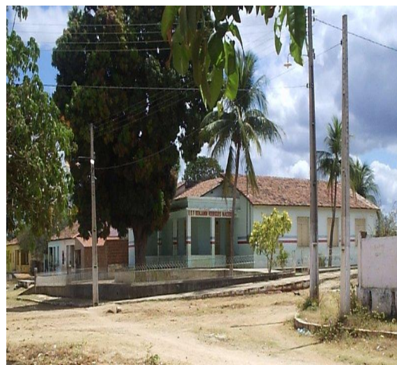
Figura 19: Prédio onde funcionou o Hotel-bar no acampamento do Açude Araras.
