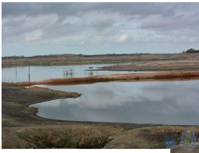
Figura 20: Barragem do Açude Ararinha, 2015 120
