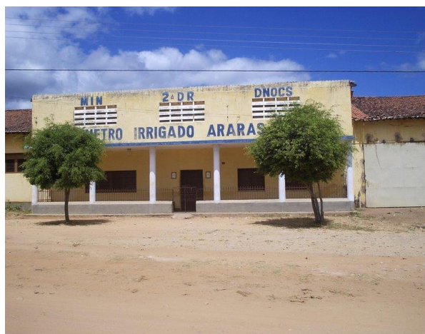
Figura 14: Aspecto atual do Escritório do DNOCS, em Varjota-CE.
