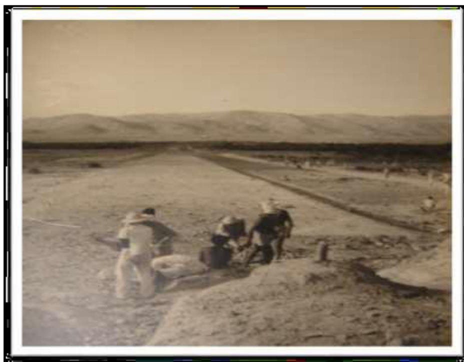
Figura 3. Trabalhadores na construção da estrada de acesso ao açude público Araras (CE) Km 3 (1951).
