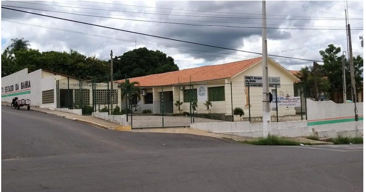
Figura 2 – EMTI - Escola de Ensino Médio em Tempo Integral Estado da Bahia – Crato ( CE)
