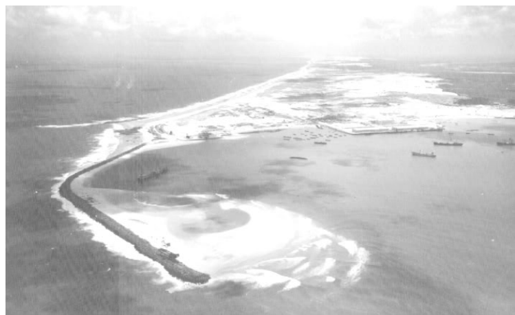
Figura 2.01 - Início da construção do porto do Mucuripe, início de 1940
