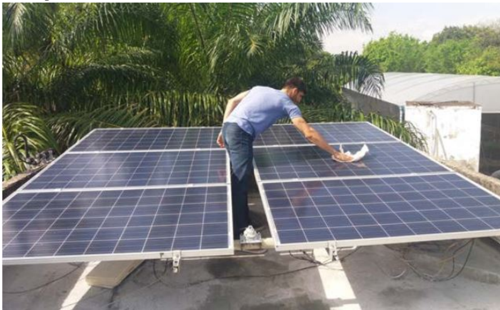
Figura 6 – Limpeza manual realizada em módulos FV.
