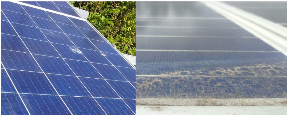
Figura 45 – Sujidade encontrada nos módulos da planta FV 2 no dia 30/09/2019.
