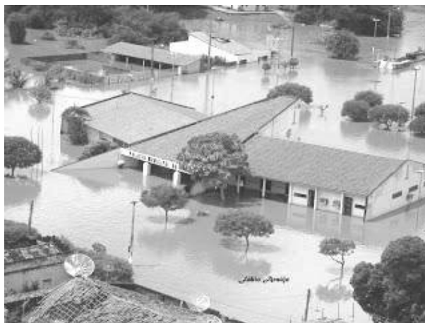
Figura 02: Alagamentos em Granja. Fonte: Diário do Nordeste.
