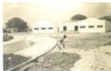
Construção do Canal
