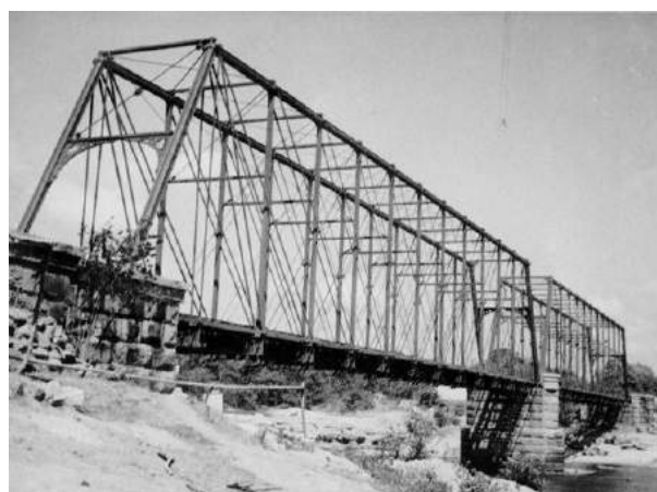
Figura 12: Ponte Metálica sobre o Rio Coreaú. Fonte: IBGE.
