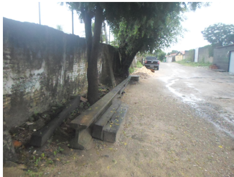
Imagem 12. Trecho da Rua Afonso Parente. Fonte: Arquivo pessoal
