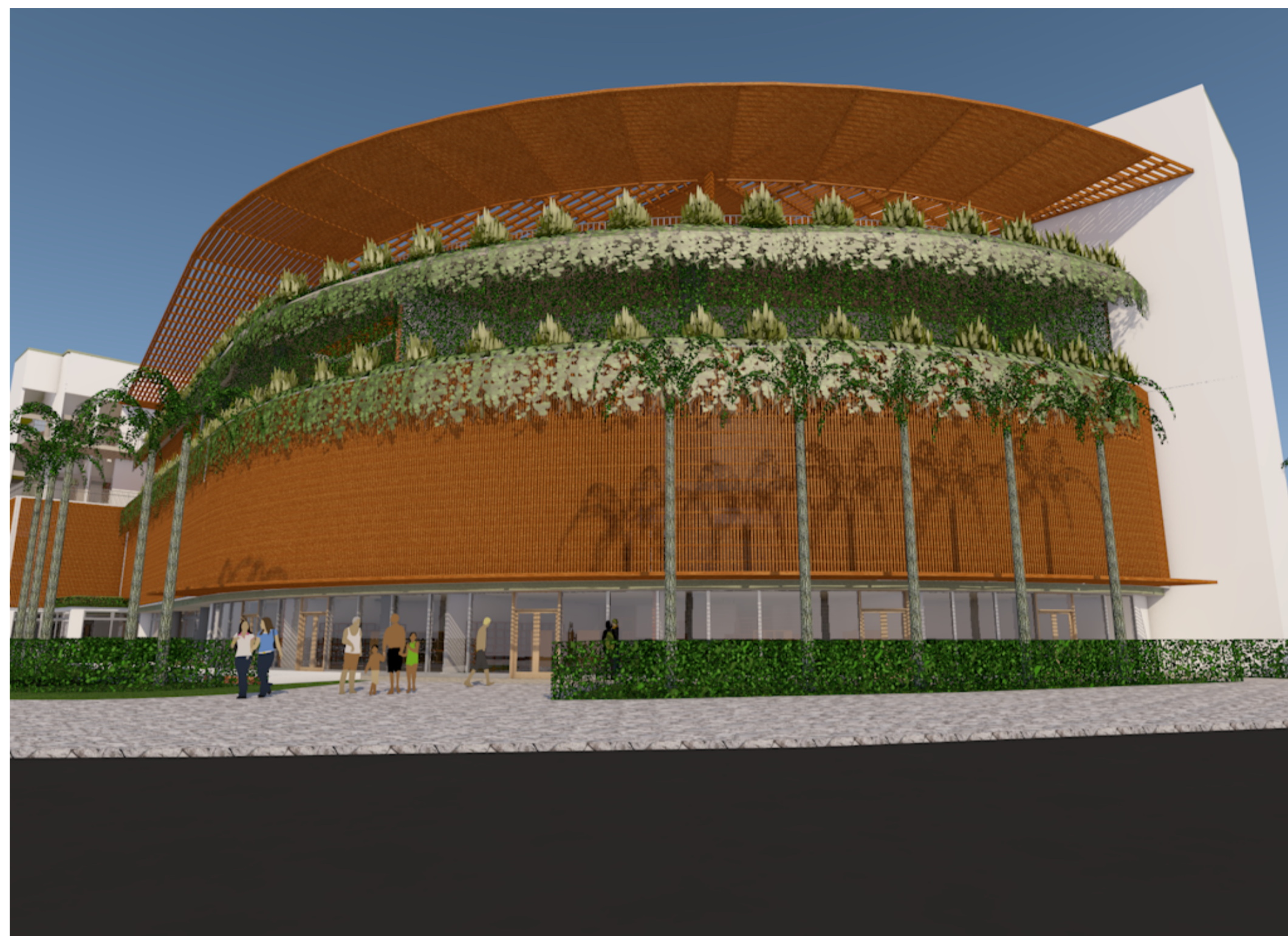
FACHADA SUL - Focada mostrando a zona de lojas, protegidas pela marquise (2,50m), engastada abaixo de uma zonada de brises de madeira.
