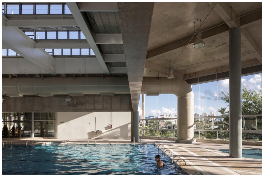
Imagem 21 – Posicionamento da área de piscina na periferia do edifício.
