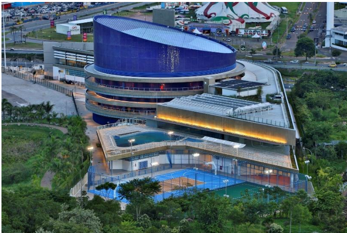
Imagem 18 – Vista aérea ilustrando a implantação do edifício.
