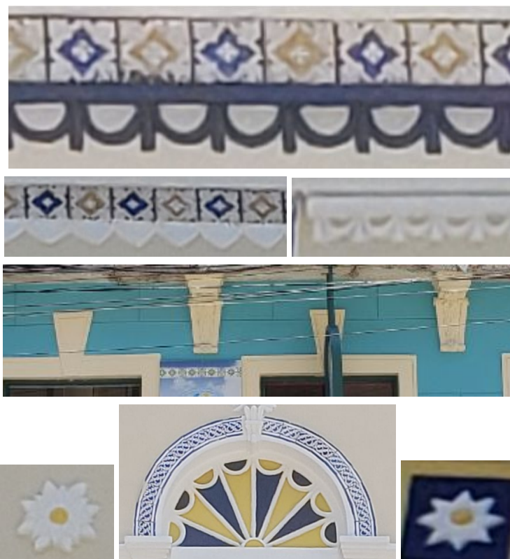
Figura 52 a 58: Elementos da fachada do Sobrado Dr. José Lourenço
