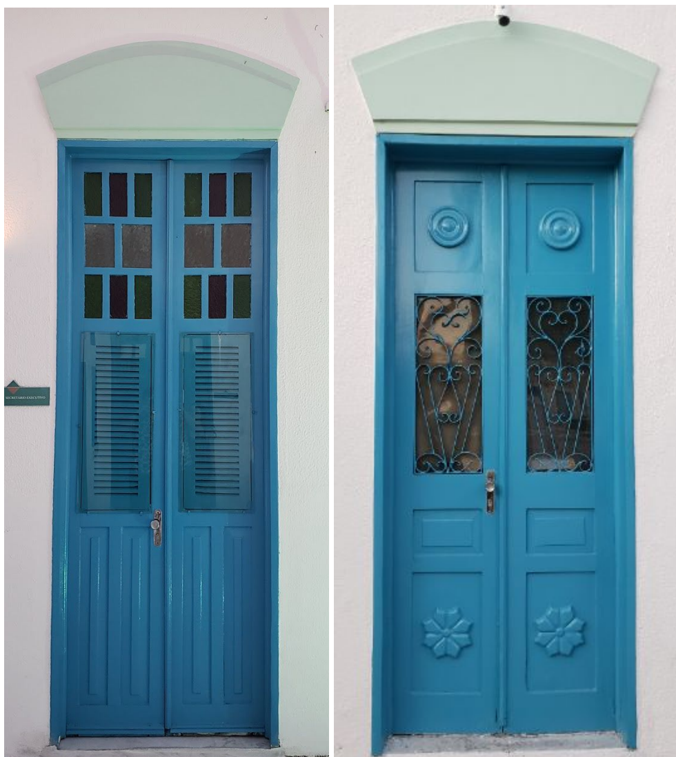
Figura 115 e 116: Portas do Estoril
