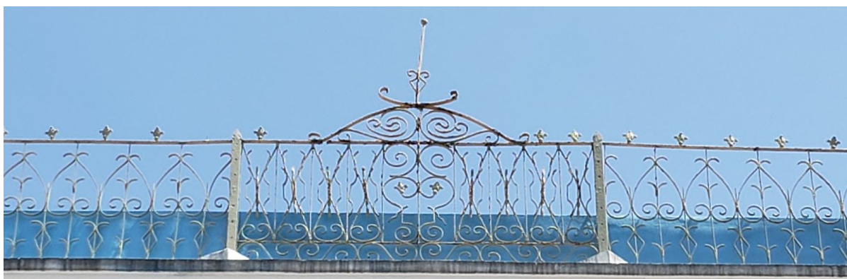
Figura 70 e 71: Grades da porta da fachada do Museu da Indústria
