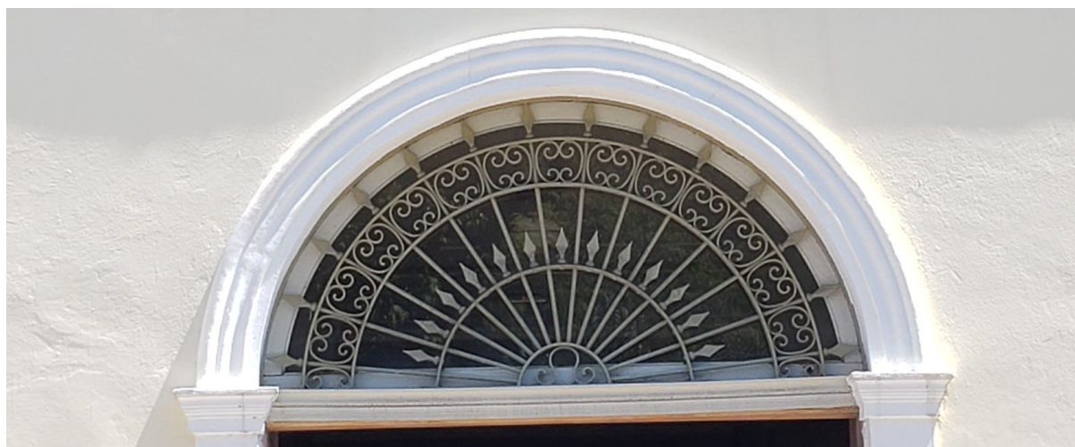
Figura 72: Gradil da porta de acesso central do Museu da Indústria
