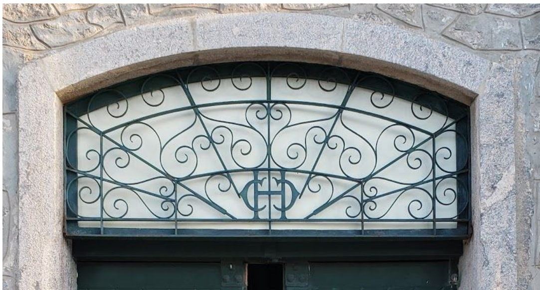
Figura 92 e 93: Grades das portas da Caixa Cultural
