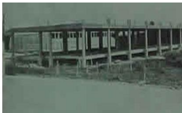
Figura 6 - Construção da MEAC Bloco principal
