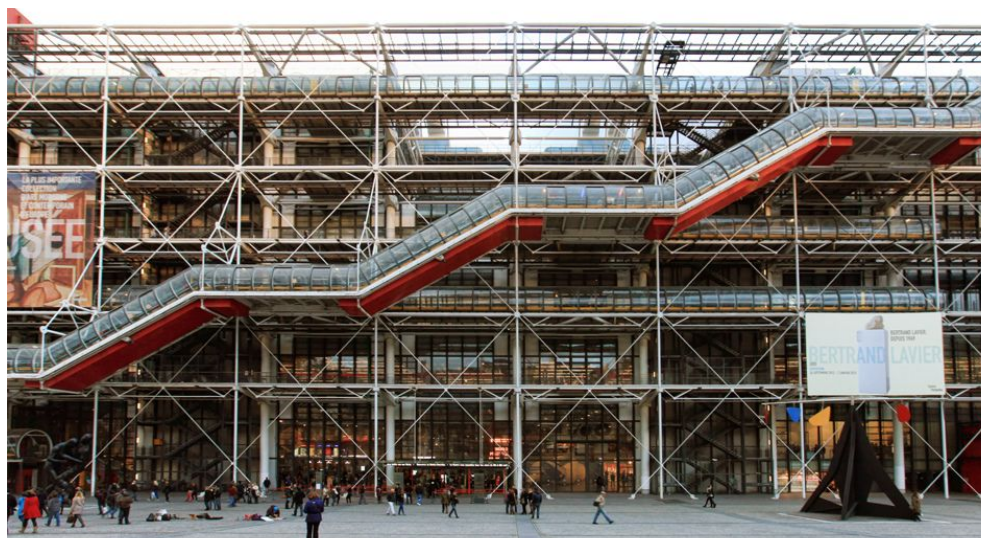
Figura 12 – Fachada do Centro Georges Pompidou. Foto: Naldo Mundim (2012)
