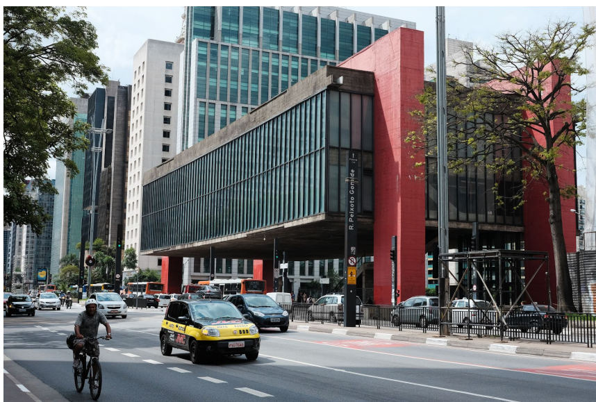
Figura 13 – Fachada do MASP
